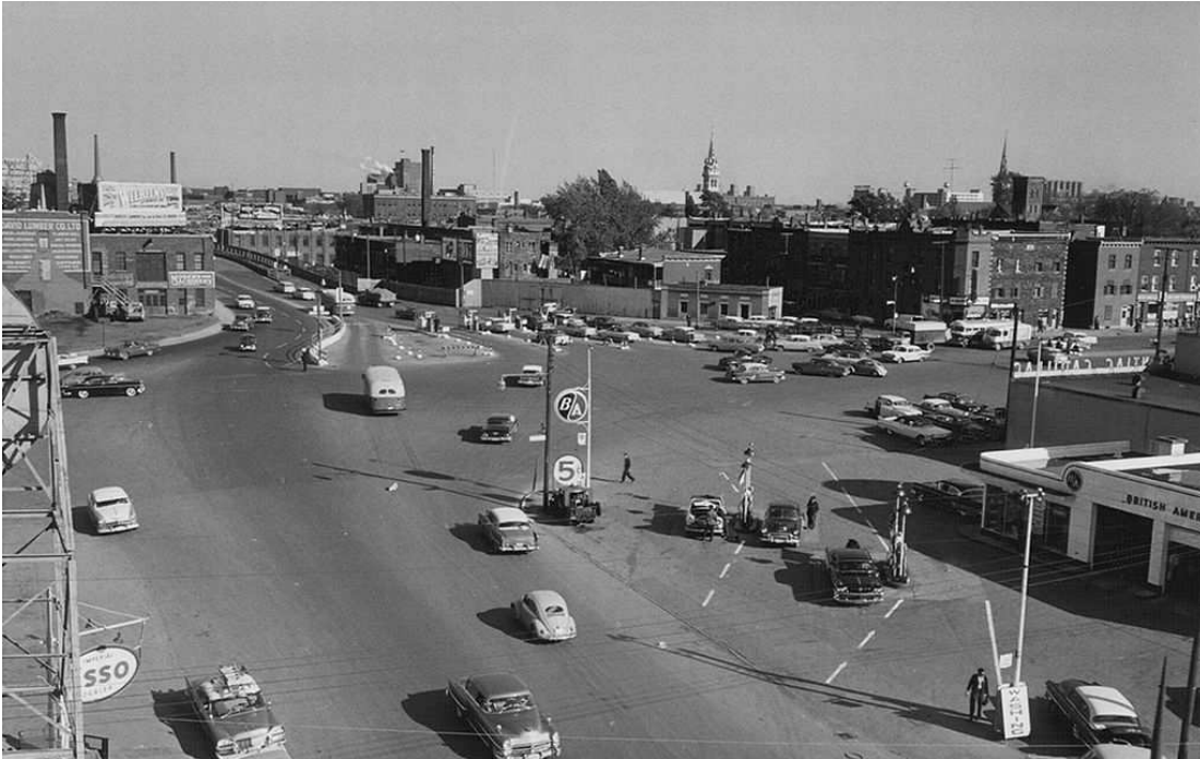
Figure 2 – L'entrée du pont Jacques-Cartier en 1958 (source : Archives de la Ville de Montréal)
