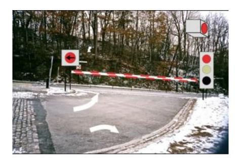
Signalisation à la jonction du sortie du terrain du stationnement du belvédère, pendant la phase **ouest.** Barrière fermée. Trois feux de signalisation, chacun avec feu rouge: un pour les sorties à la gauche, un autre pour les sorties à la droite, et un en face de la montée vers l'ouest par Camillien Houde. Les flèches blanches sont à peinturé sur l'asphalte.
