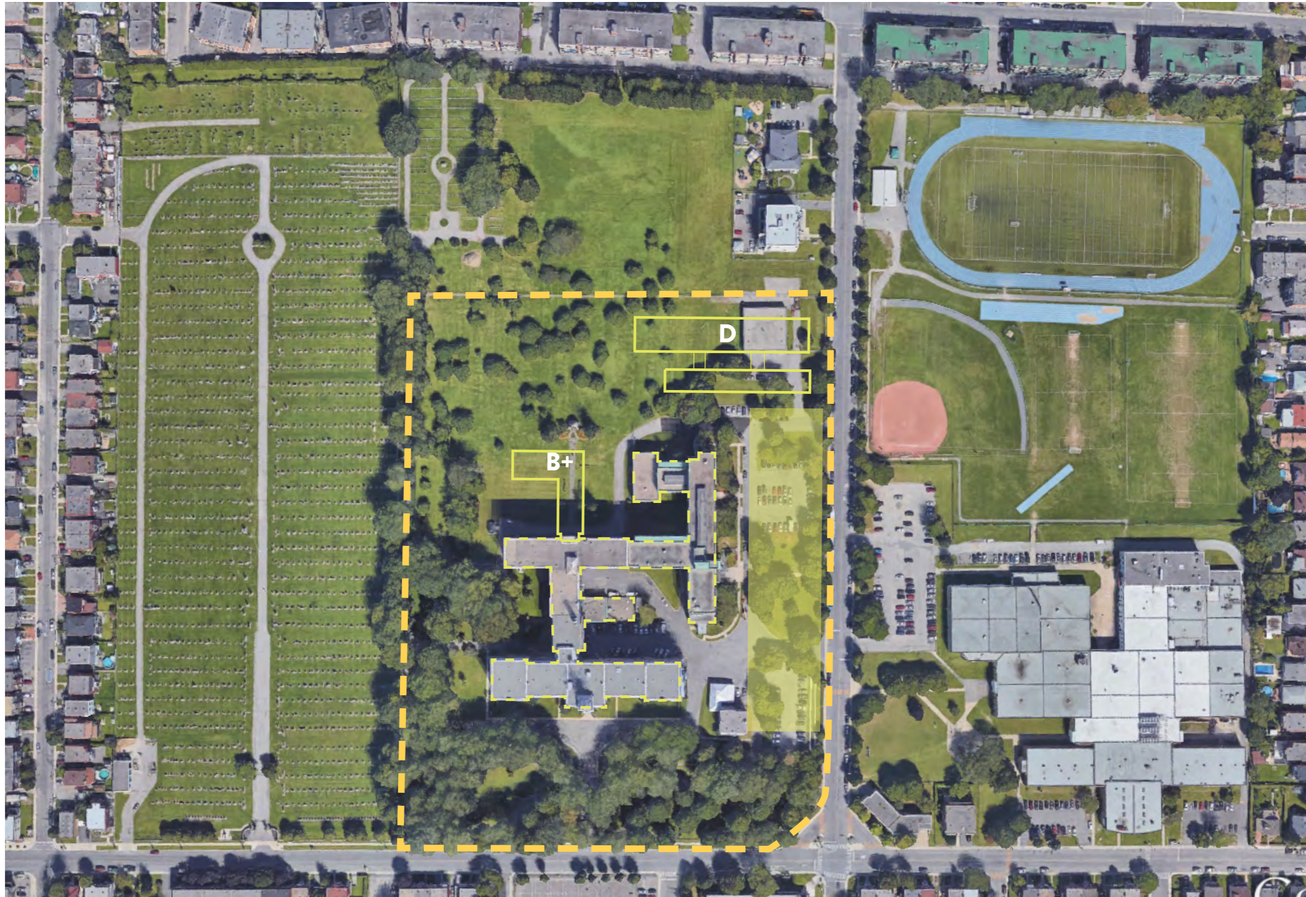
Implantation / vue aérienne sur le site
