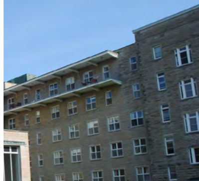
Jonction arrière entre bâtiments B et C
