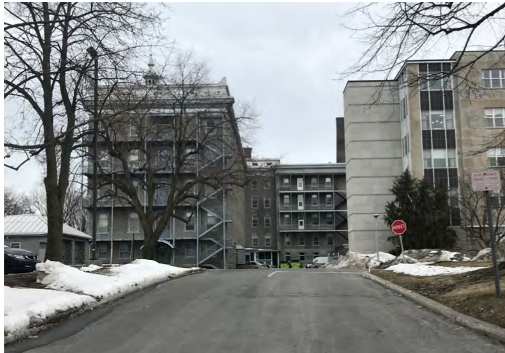
Cour existante formée par les bâtiments A, B, C
