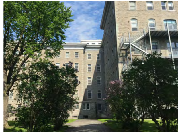
Jonction entre les ailes A et B
