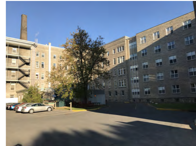
Cour intérieure entre les ailes A, B et C
