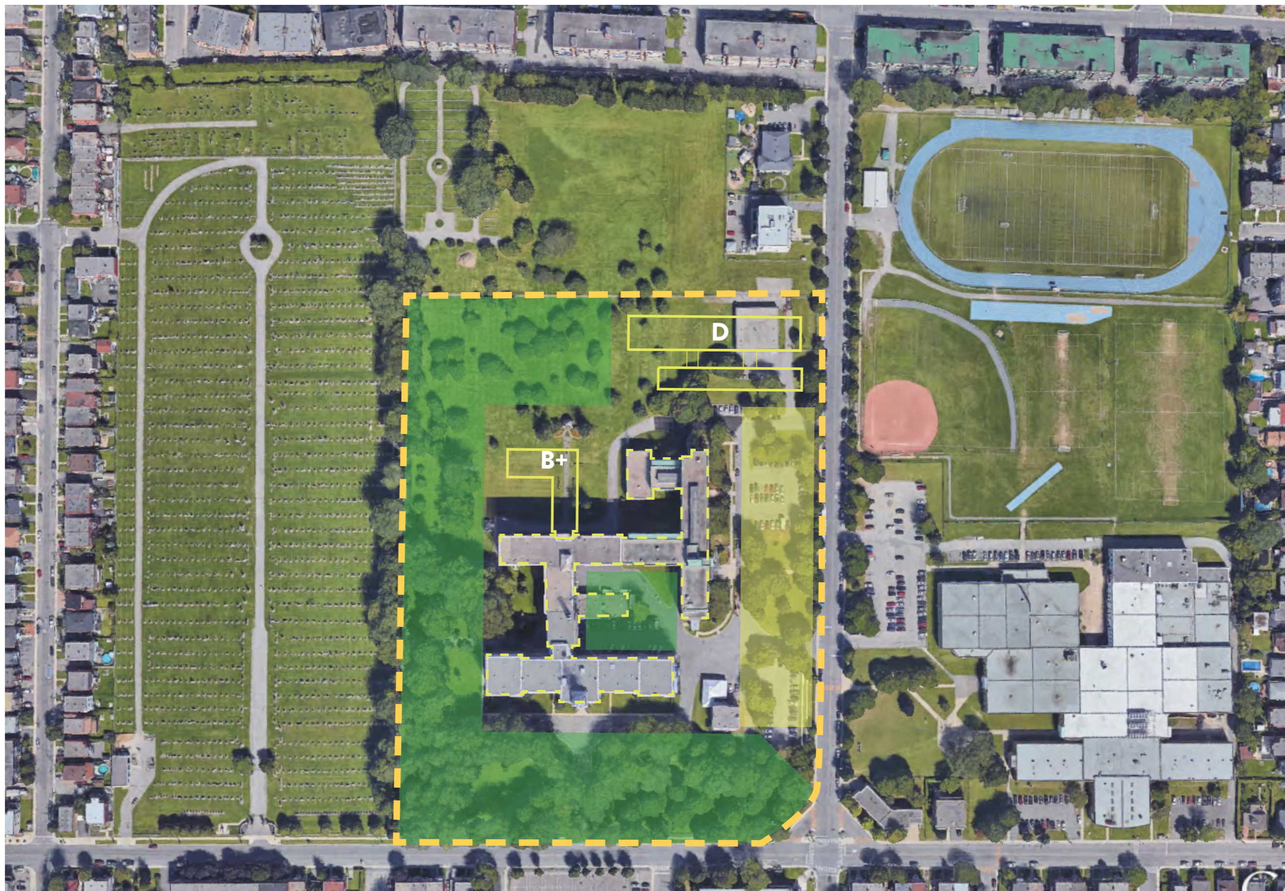
Implantation / vue aérienne sur le site
