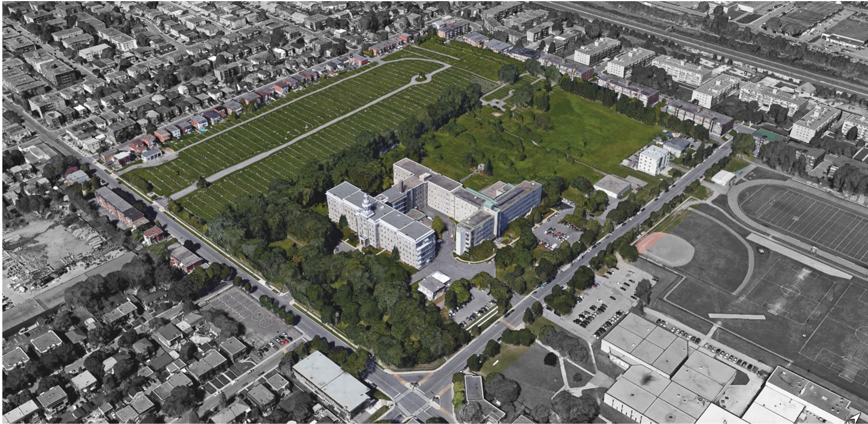
Vue aérienne - Ensemble du site dans son contexte
