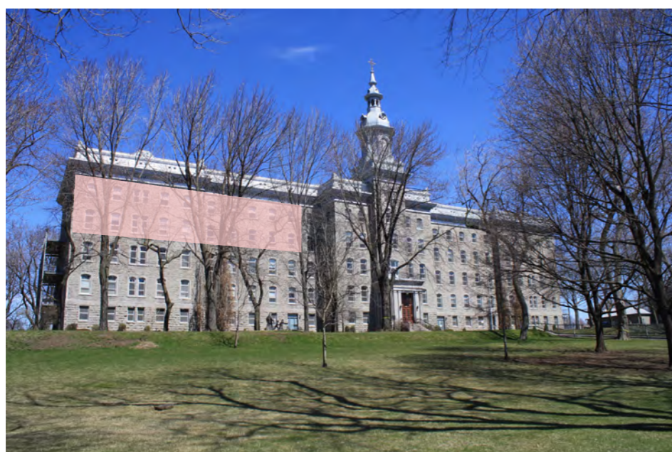
Emplacement de la chapelle
