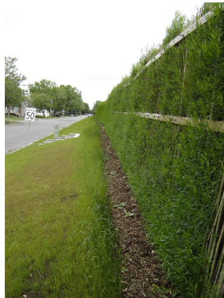
Figure 13: photo montrant la barrière sonore végétale, côté rue (crédit photo : Michel Labrecque, IRBV)
