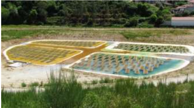
Traitement des eaux de drainage de la mine d'uranium Cunha Baixa, Mangalde (Viseu, Portugal)
