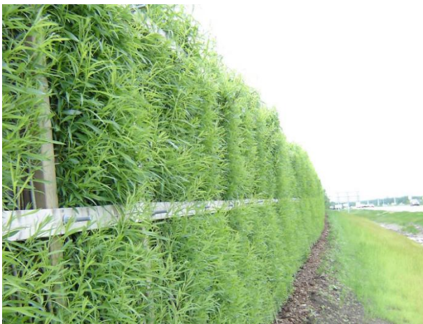
Figure 14: photo montrant la barrière sonore végétale, côté autoroute (crédit photo : Michel Labrecque, IRBV)
