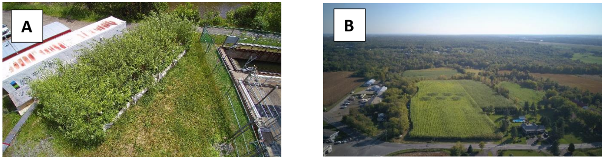
Figure 3 : Traitement d'eaux usées primaires. Les eaux sont acheminées à la FPS (A) ou aux PFS (B) pour assurer leur irrigation). Note : les surfaces de la PFS irriguées montrent une croissance plus marquée des saules (plus grande hauteur des tiges, plus grand diamètre des troncs, intensité plus marquée de la couleur des feuilles), ce qui tend à montrer que la matière organique, l'azote et le phosphore ont été captés par les végétaux pour leur développement (B, voir carrés vert foncé). Les photos présentées ont été prises durant la deuxième saison d'expérimentation. (crédit : Simon Amiot, IRBV)
