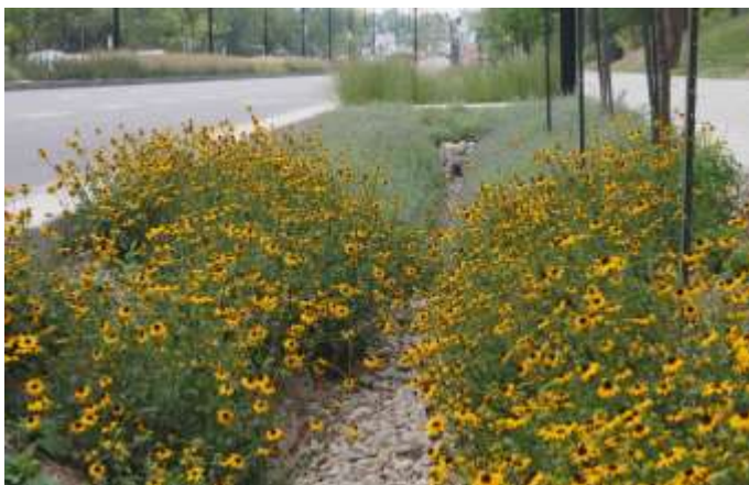
Cellules de biorétention, rue Papineau, Montréal (Québec)
