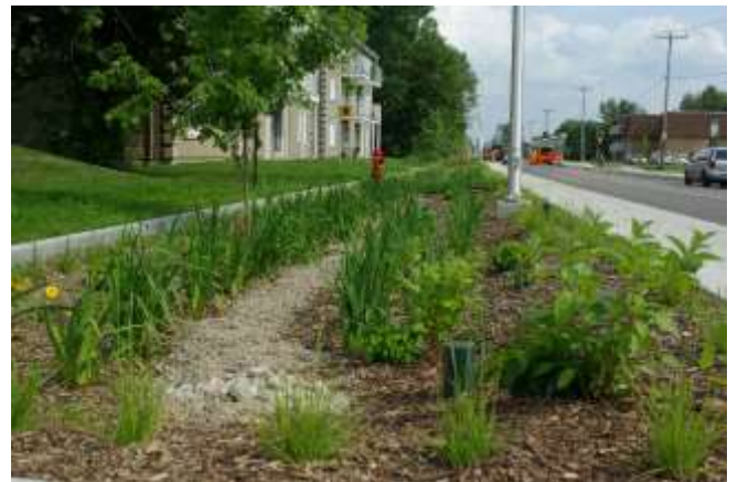
Cellules de biorétention, rue Saint-Charles, Trois-Rivières (Québec)
