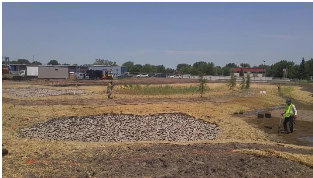
Figure 7 : phase de plantation (juillet 2018) (crédit: Fiducie des installations pétrochimiques de Mtl est)
