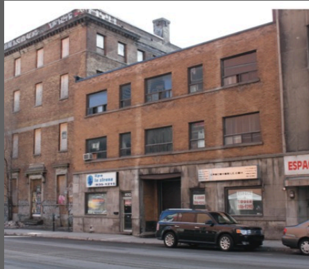
2 1170, RUE SAINT-ANTOINE OUEST
