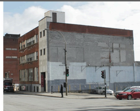
4 1240, RUE SAINT-ANTOINE OUEST
