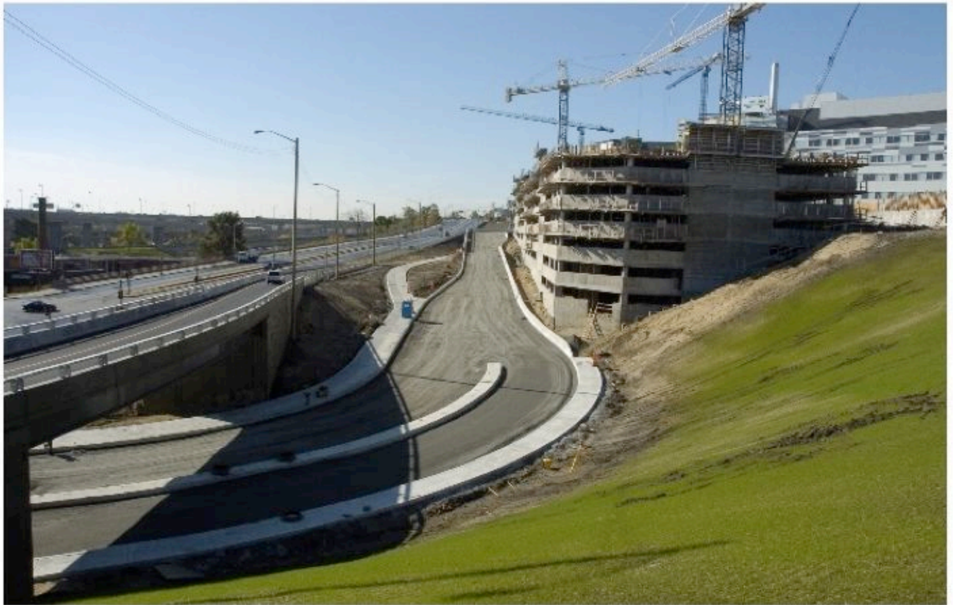
L'accès de service permanent au CUSM prend forme (17 octobre 2012)
