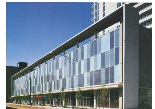
Exemple de stationnement intérieur intégré à un immeuble commercial et résidentiel, à Chicago.
