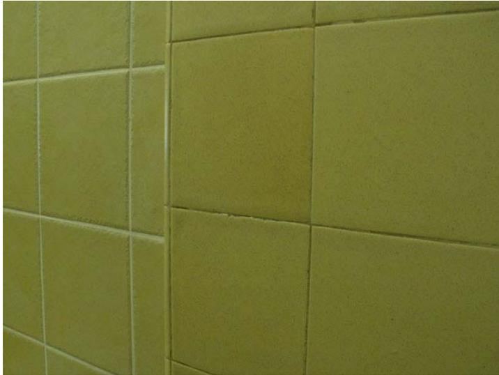
Figure 35 : Carreaux de céramique originaux et carreaux de remplacement à l'intérieur du Quartier général des incendies. Claudine Déom, 2006.
