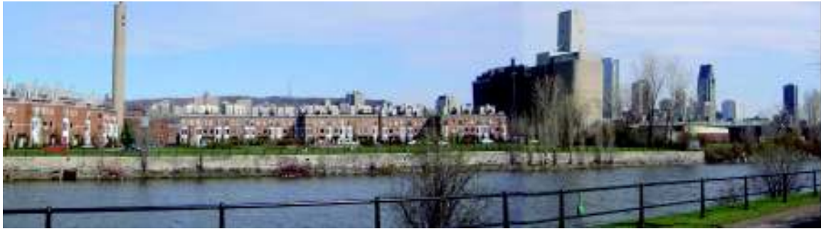
Canal de Lachine (rue Ropery)
