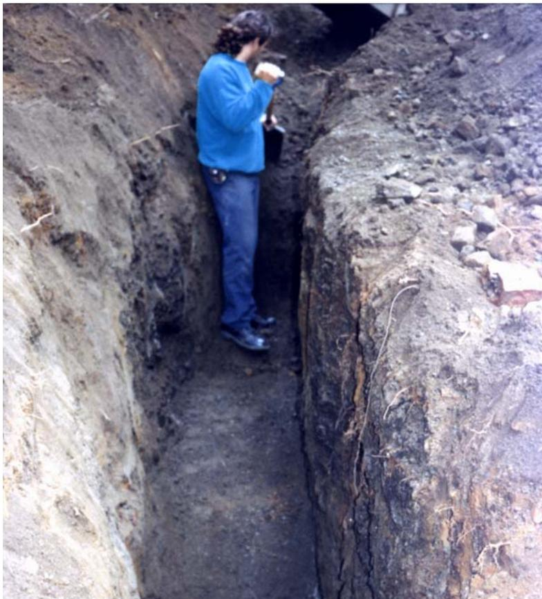
Excavation de la clef pour assurer l'étanchéité d'une des digues naturalisées
