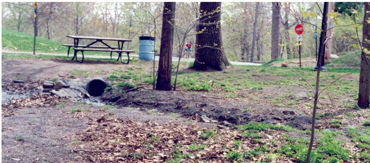
Le secteur du muret-digue avant les travaux, remarquer le tuyau sous les racines d'arbres
