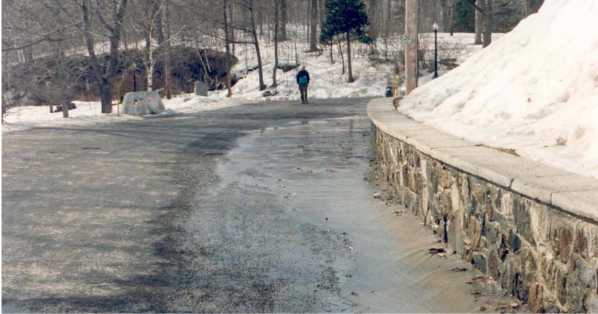
Avant la construction du muret-digue, débordement d'égout pluvial, érosion du chemin Olmsted derrière le chalet, écoulement des eaux vers le belvédère Kondiaronk le long d'un muret
