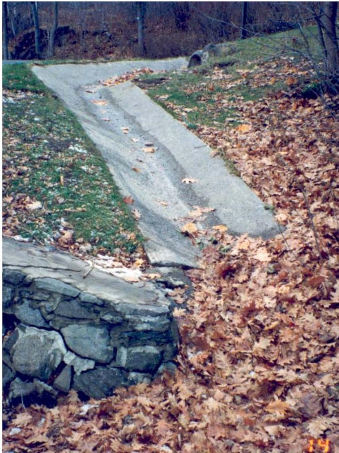
Caniveau en béton qui se déversait les eaux sous le pont, avant les travaux
