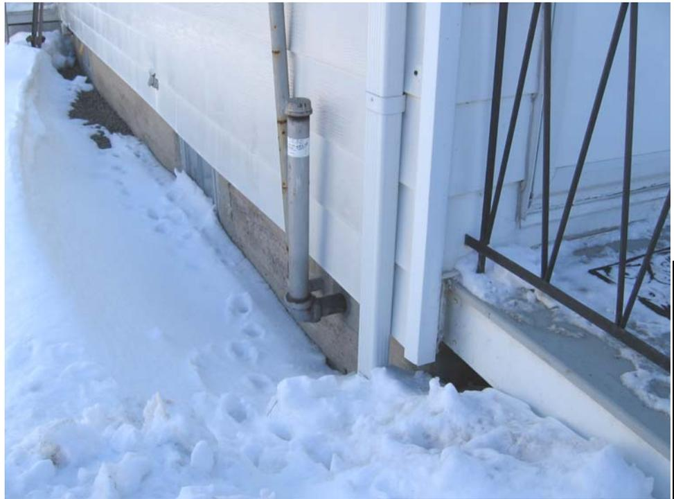
**Photo n° 4.** Photo des conduits d'évent et de remplissage de l'un des réservoirs d'huile à chauffage observé sur les propriétés bordant la rue Contrecoeur.
