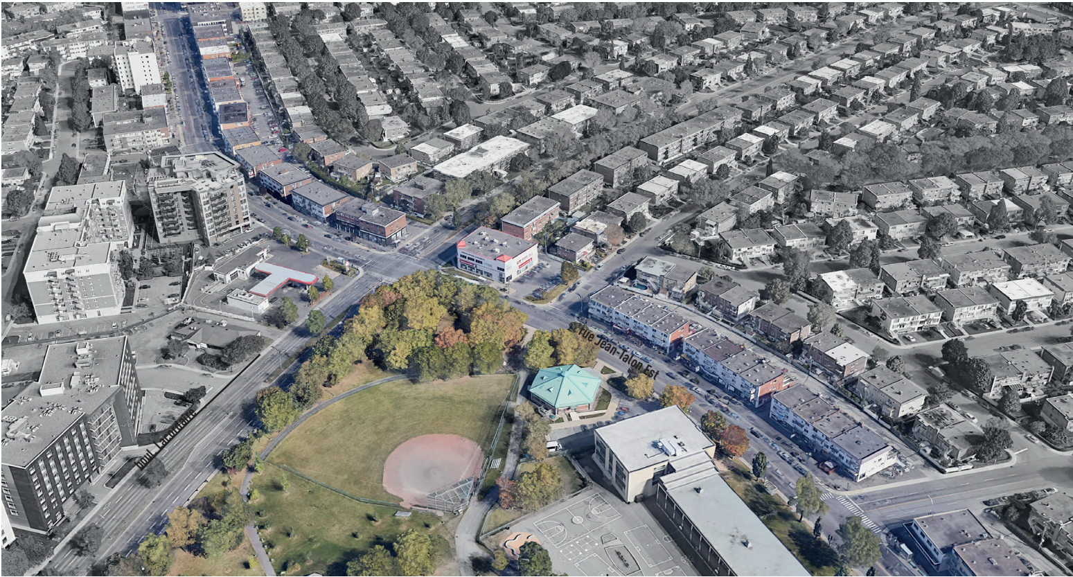
Illustration des composantes d'intérêt significatif, soit la trame urbaine de la rue Jean-Talon Est, entre les rues Dollier et Valdombre © Google Earth
