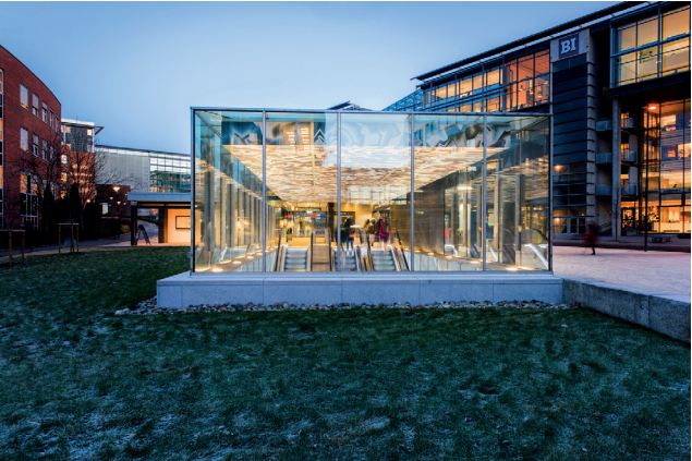
Édicule pavillonnaire, Oslo, Norvège © Archdaily
