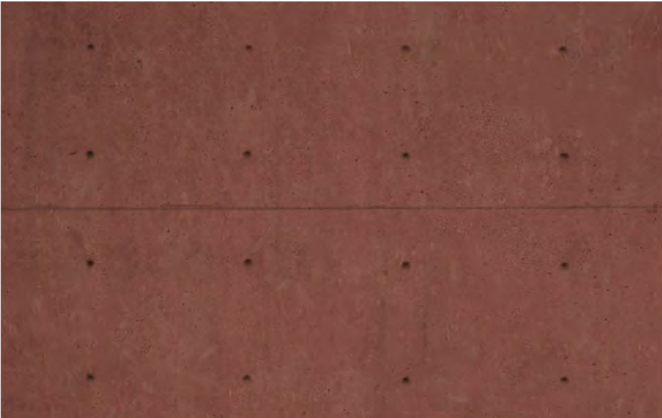
BÉTON ARCHITECTURAL, PIGMENTÉ ROUGE
