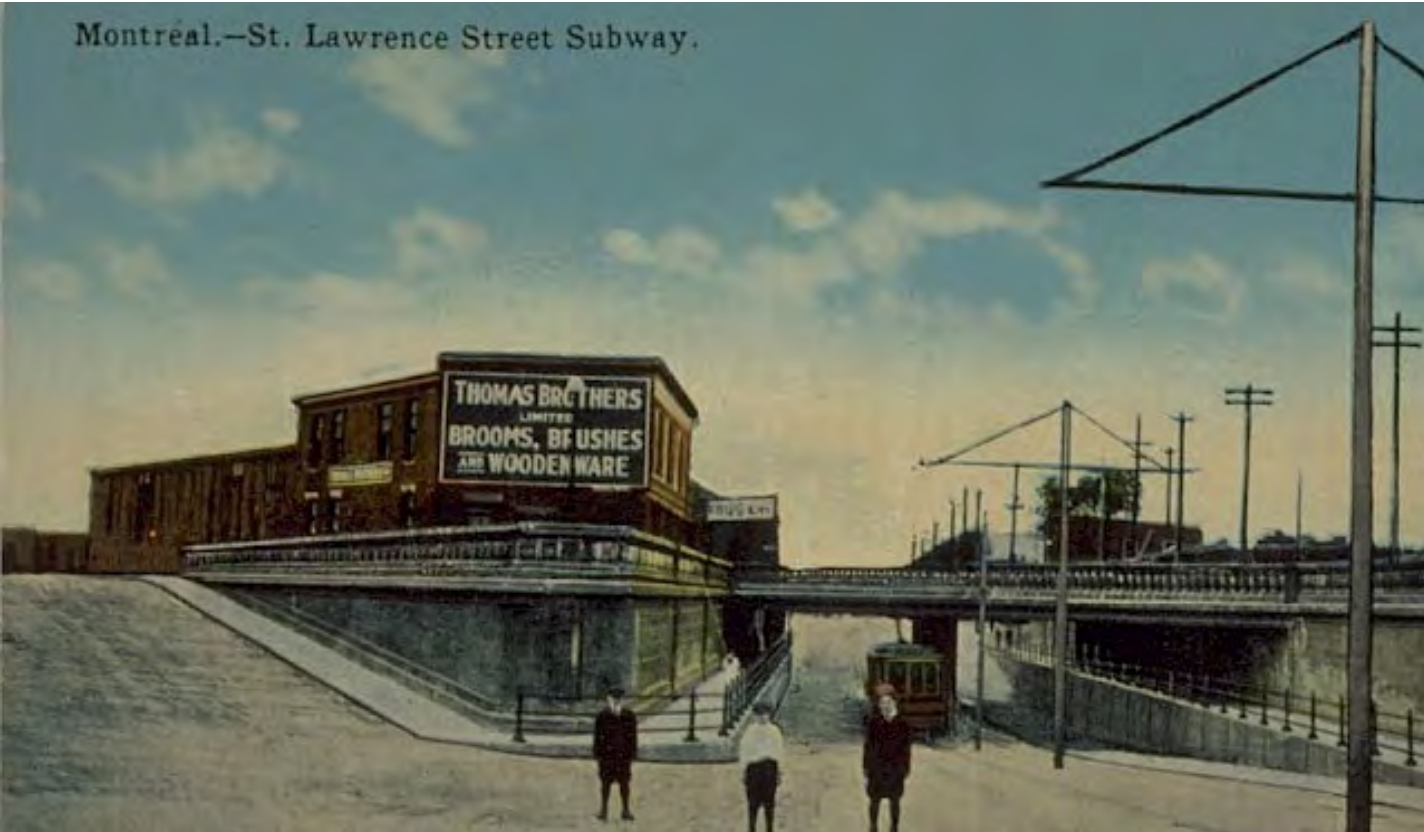
Vue du nouveau viaduc sous la voie ferrée. - 1911 BanQ - carte postale
