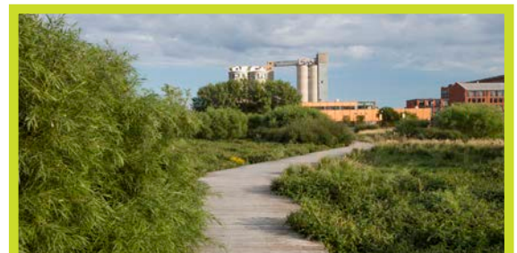
Bassin de biorétention sec
