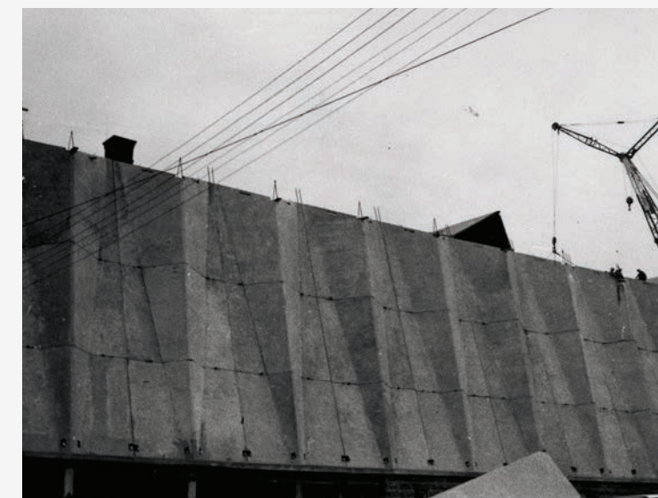
Assemblage des panneaux de béton de la chapelle (source: Archives provinciales)
