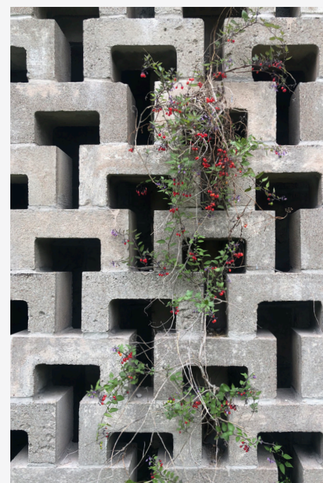
Soubassement en béton
