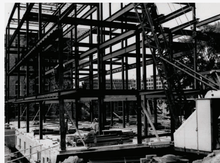
Construction de l'infirmerie provinciale (source: Archives provinciales)
