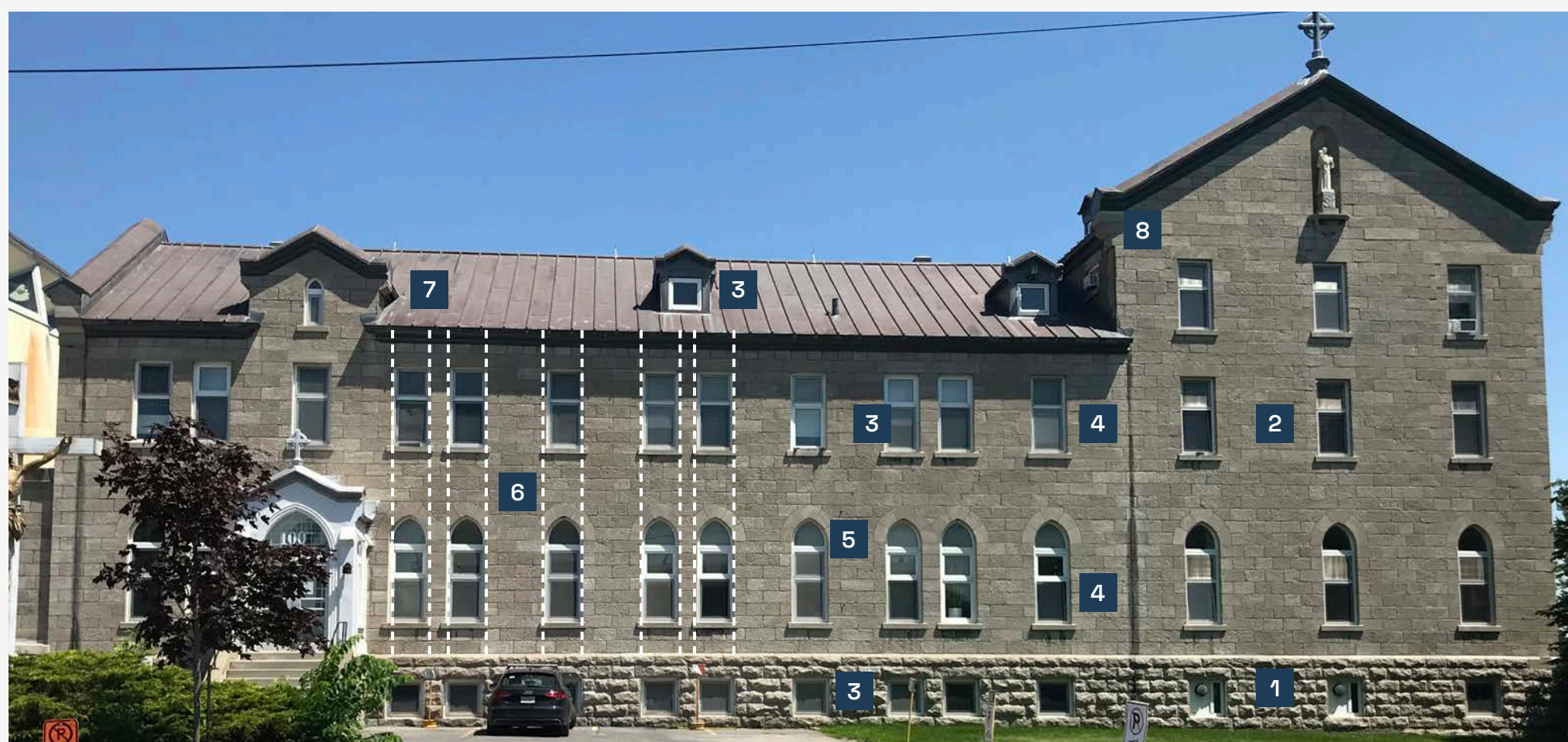
Photo de la façade ouest du couvent, 2018
