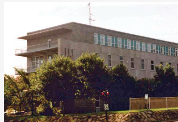
Infirmerie provinciale vue depuis l'intersection Dickson et Rosemont (source: Archives provinciales)
