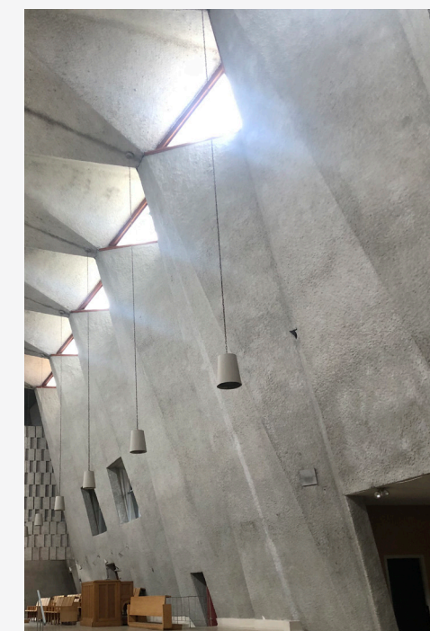
Mur en voile de béton
