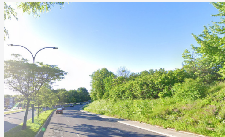
Talus existant sur Dickson Secteur de conservation des arbres en bon état
