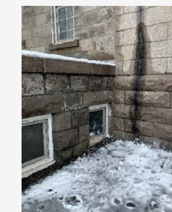
Fenêtres au coin sud-ouest: le niveau du sol atteint l'appui des fenêtres (source: Idem)
