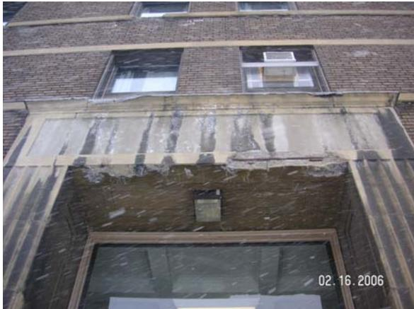
47 : Décor en béton de l'entrée avec une barre d'armature apparente.
