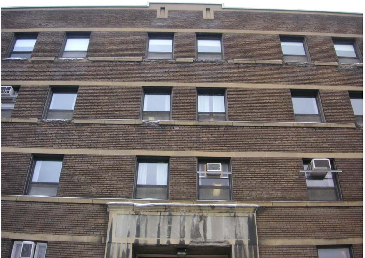
48 : On note le problème des bandeaux de béton principalement localisés sous les fenêtres.
