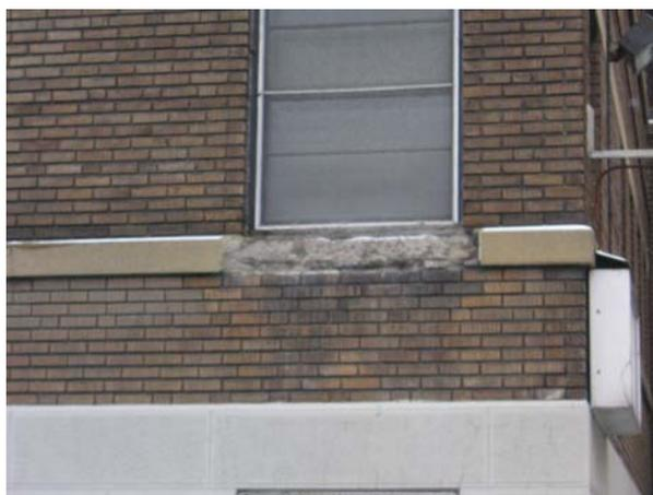
46 : Bandeau de béton préfabriqué brisé au niveau des fenêtres.
