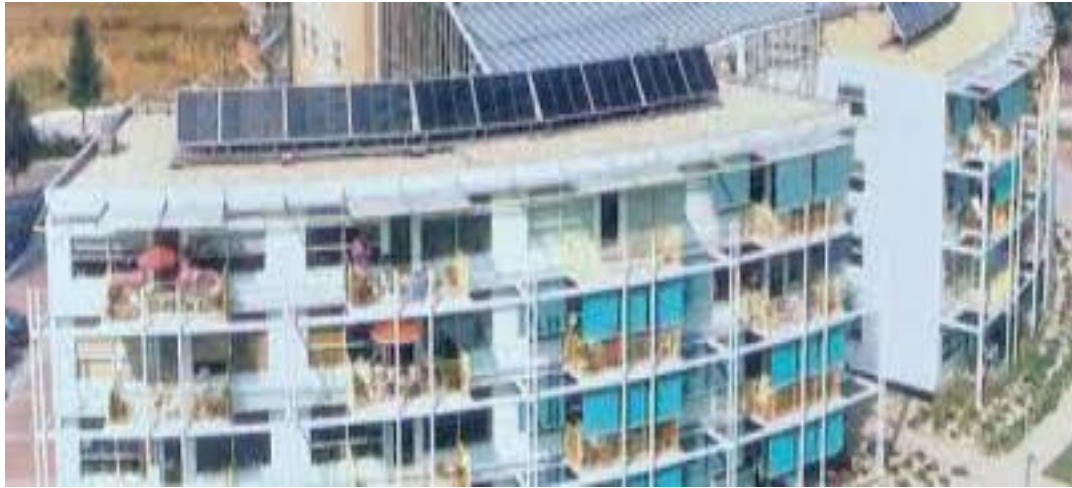
Panneaux solaires situés sur le toit
