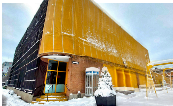
L'Escalier circulaire - un projet d'occupation transitoire à l'initiative de la Ville de Montréal et géré par Entremise.
