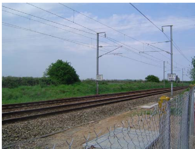
Figure 9 : Système caténaire 25 kv
