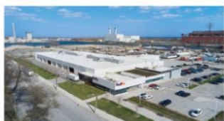
FedEx Commissioners Street Complexe industriel de 7 432m 2 /80 000pi 2 Construit en 2015 sur 2 hectares de terrain Toronto, ON
