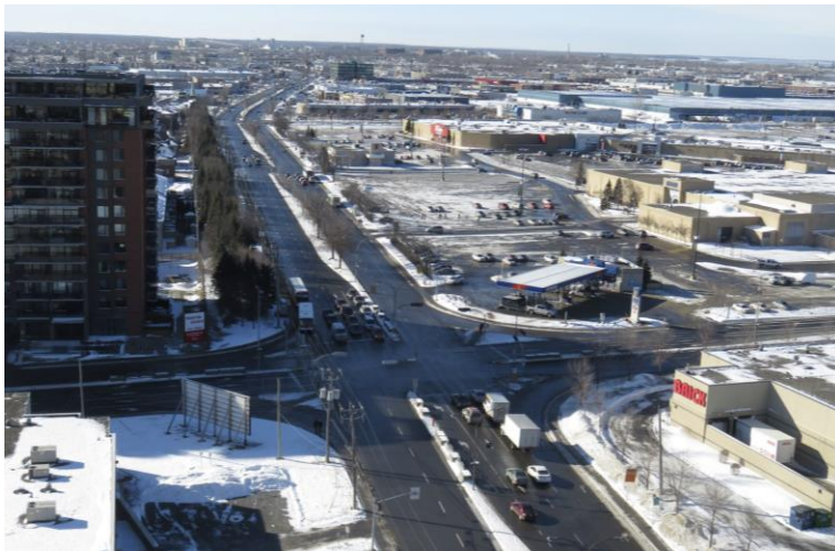
Centre commercial à transformer
