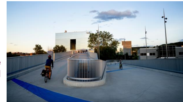
Lien actif sécuritaire au-dessus des voies ferrées ©Vincenzo D'Alto
