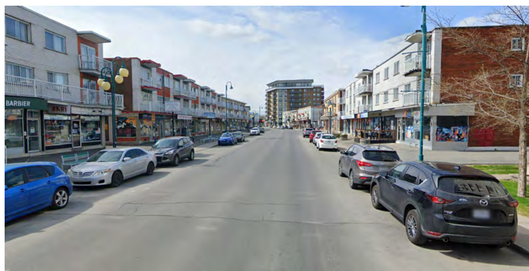
↳ La trame urbaine à échelle humaine est ponctuée de bâtiments de hauteur importante localisés à proximité des intersections et venant marquer le paysage urbain © Google Street View
