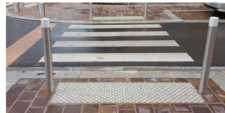
Surface podotactile facilitant la compréhension de l'espace par les personnes ayant des limitations fonctionnelles © Cent degrés
