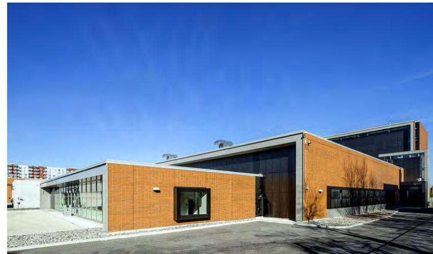
Le poste Bélanger après sa reconstruction
