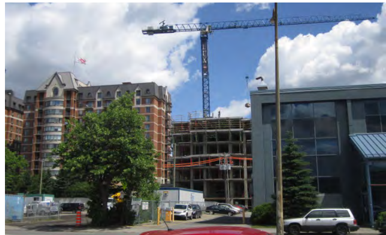
Résidence pour personnes âgées et deuxième phase en construction, vues depuis le boulevard de l'Assomption
