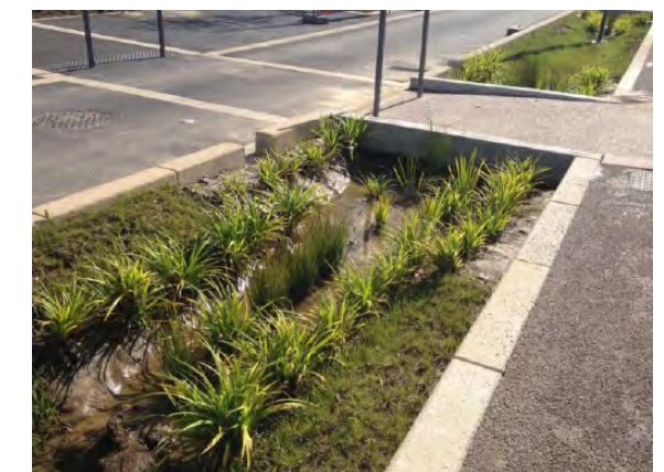
PHOTO 35: NOUE VÉGÉTALISÉE, DOUAI, FRANCE
