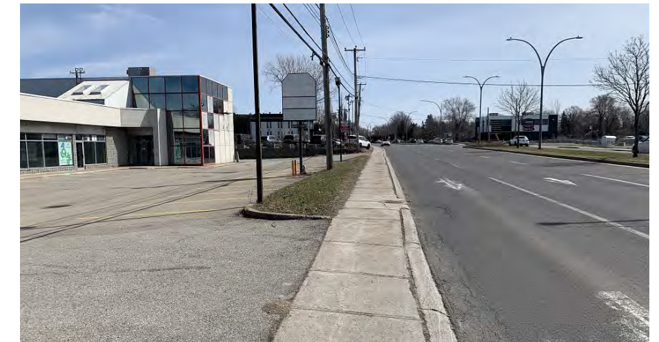
PHOTO 18: FORTE PROPORTION DES AMÉNAGEMENTS D'EMPRISE ET DES PROPRIÉTÉS PRIVÉES MINÉRALISÉES
