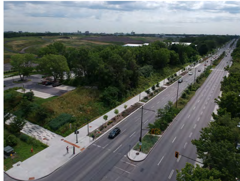
PHOTO 30: PLANTATION (ARBRES, ARBUSTES, VIVACES) ET NOUES DRAINANTES LE LONG DE L'AVENUE PAPINEAU À MONTRÉAL
