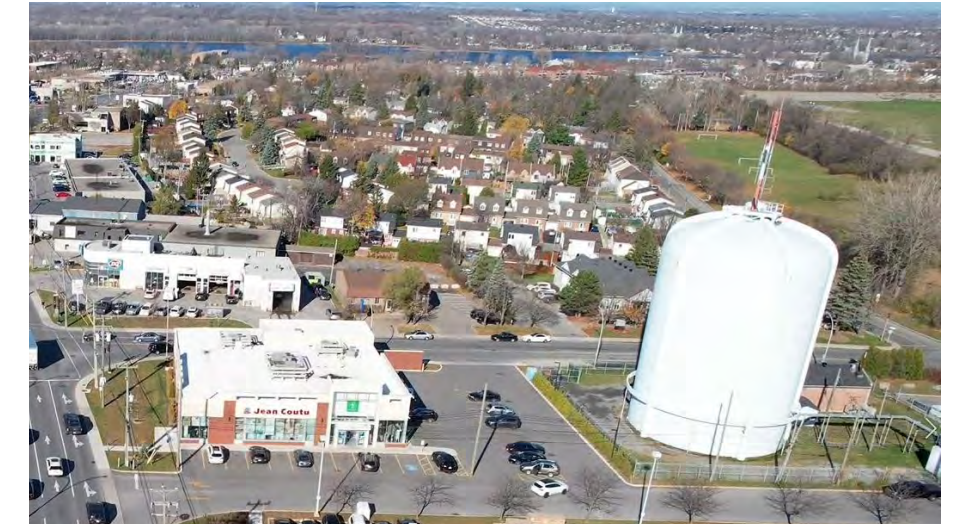
PHOTO 25: RÉSERVOIR D'EAU DE LA STATION DE POMPAGE ST-CHARLES
