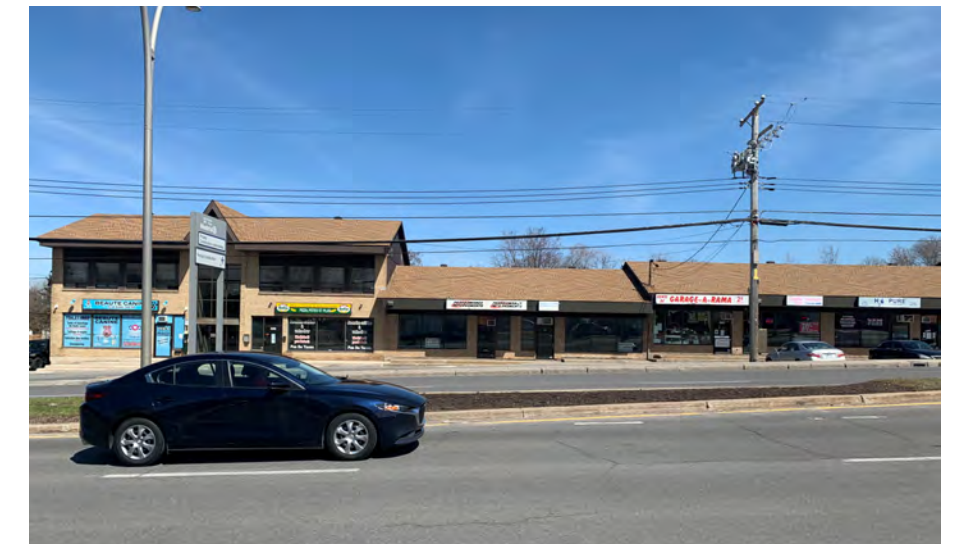
PHOTO 23: FLUCTUATION DES HAUTEURS
