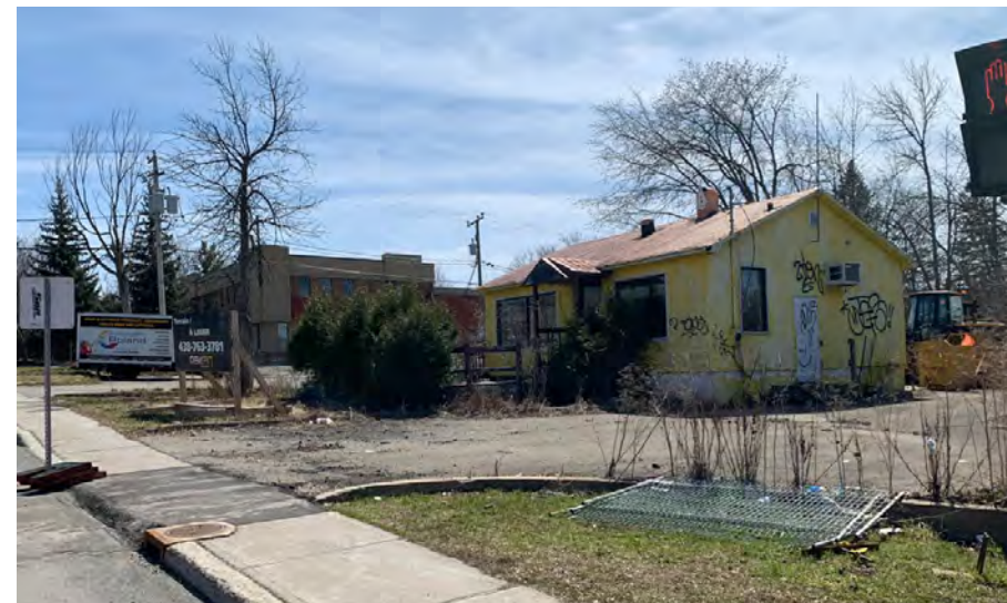
PHOTO 22: BÂTIMENT DEVANT FAIRE L'OBJET DE RÉNOVATION
