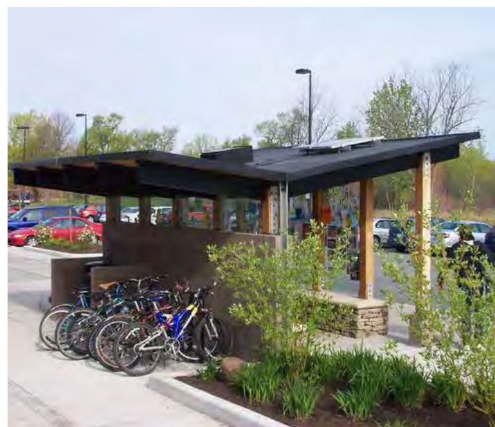
Fig. 300. Stationnement pour vélo abrité (Source: GFLRPC)
