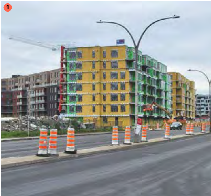
Fig. 4. Projet Curtiss Condo en construction (Source : Groupe BC2)
