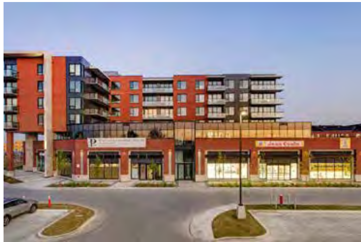
Fig. 64.Bâtiments mixtes du quartier Bois-Franc (Source: groupemonclair.com)
