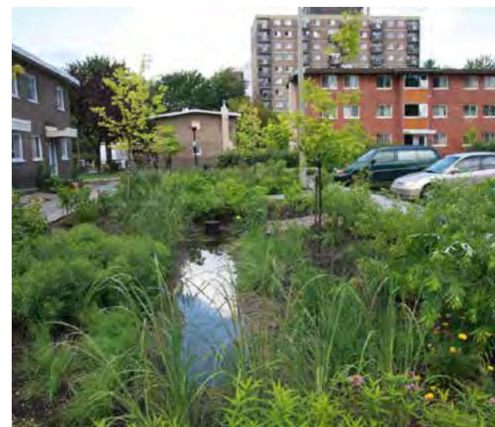
Fig. 301. Noue paysagère en bordure d'un stationnement de surface, Habitations Jeanne-Mance, Montréal (Source: Médiaterre)
