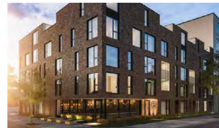
Fig. 252. Immeuble à logement multiple mixte de 5 étages, Rosemont-La-Petite-Patrie, Montréal (Source: Guide Habitation)
