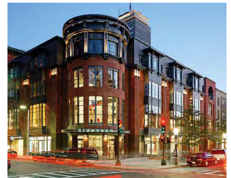
Fig. 269.Marquage de l'entrée principale, Boston, États-Unis (Source: Newbury Street)
