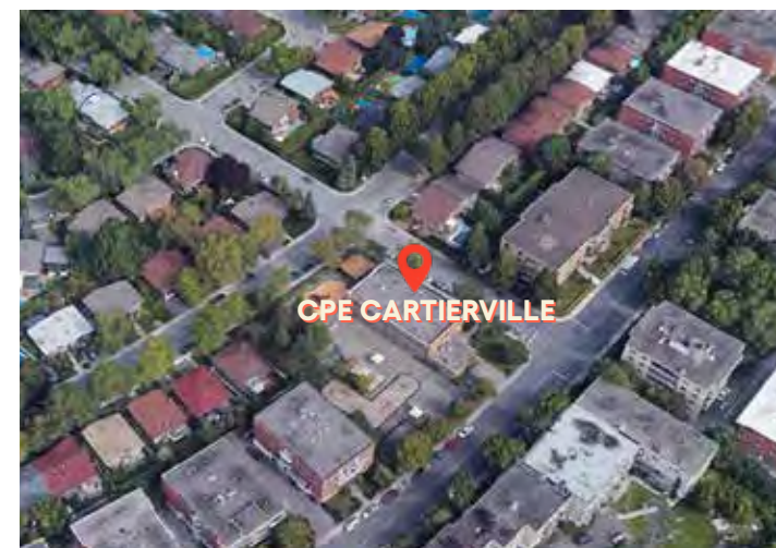
Fig. 286. Immeuble du 11 760, avenue Robert-Giffard (CPE Cartierville, CSDM) (Source photo: Google Maps)
