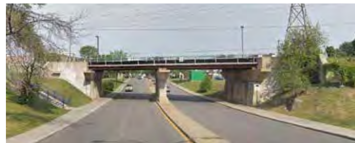
Fig. 88. Rue Grenet (Source: Streetview, Août 2018)
