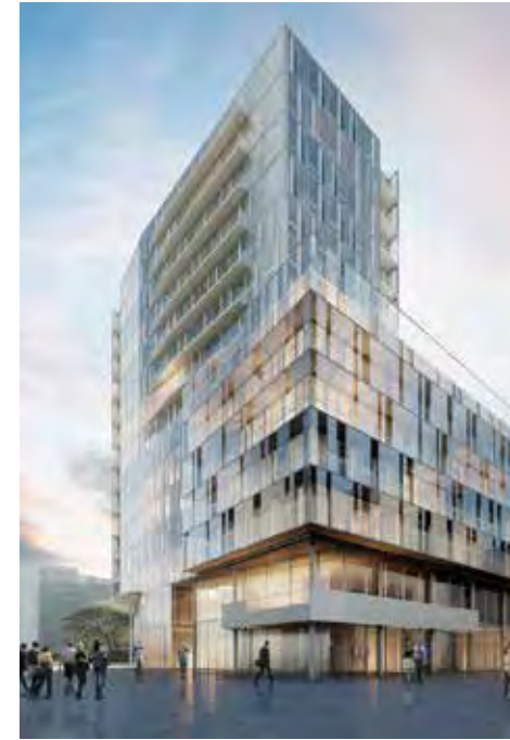
Fig. 263. Modulation volumétrique et gradation des hauteurs, Hambourg, Allemagne (Source: Richard Meier & Partners)
