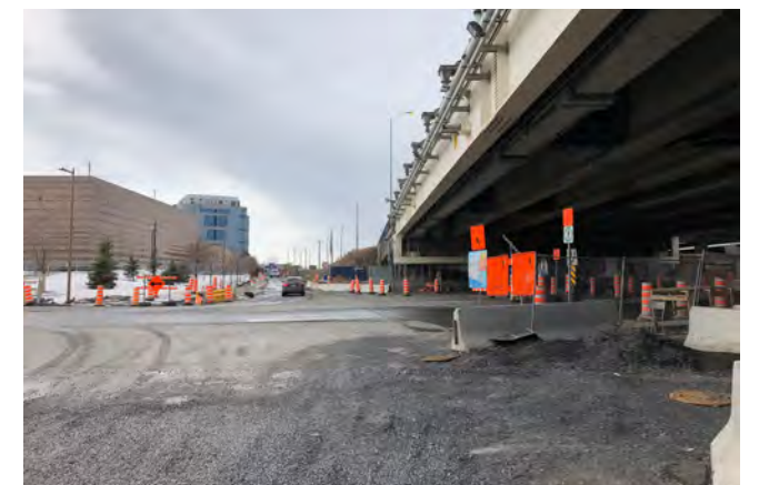
Bretelle d'accès A-15 sud
