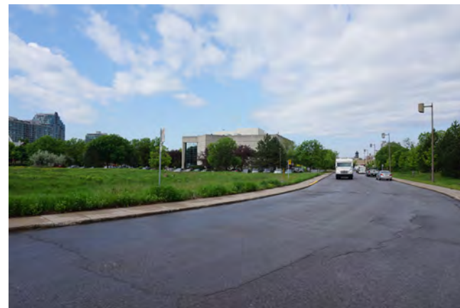
État actuel de la rue Levert
