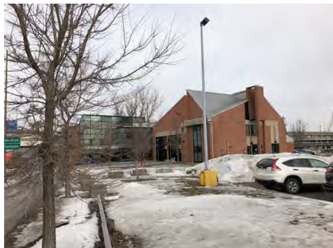
Trottoirs manquants le long du boulevard René-Lévesque
