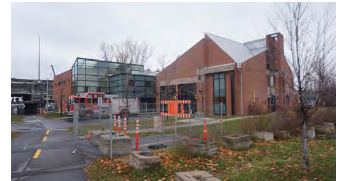
Caserne de pompiers
