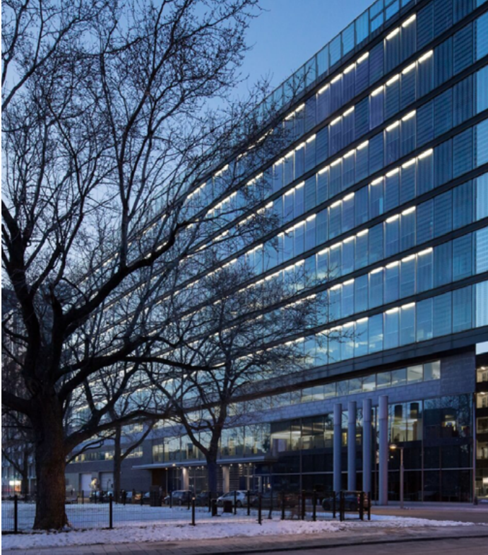
L'édifice Louis-Charland, la phase VIII du projet de la Cité du multimédia, qui a donné l'impulsion nécessaire à la requalification du Faubourg des Récollets a été réalisée grâce à l'intervention foncière de la Ville de Montréal par l'entremise de la Société d'habitation et de développement de Montréal (SHDM). (© Marc Cramer)
