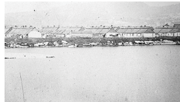
Baraquements pour les malades atteints du Typhus, puis pour loger les ouvriers du pont Victoria (1858-59) Source : Musée McCord, coll. Notman - Recadrée
