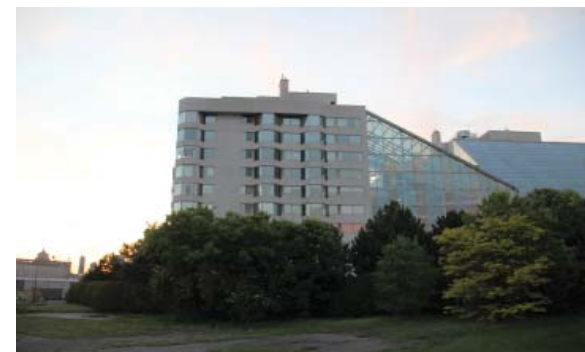
Vue sur la face sud de Tropiques Nord, 2019 Photo : Ariane Malo-Sauvé
