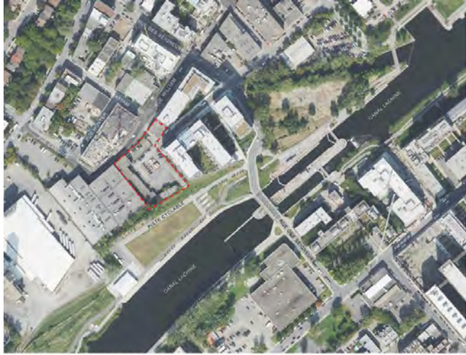
2. Vue aérienne du quartier. Proximité avec le canal Lachine, 1550 urbanisme de Giffney
