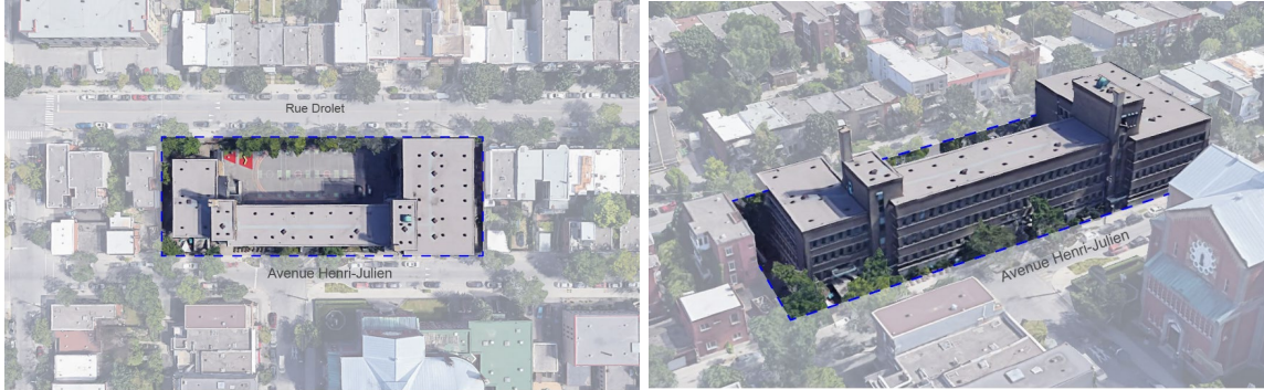
Figure 3. L'école La Petite-Patrie, pavillon Notre-Dame-de-la-Défense (superficie de plancher de 6064 m 2 ). Source : Google Earth, modifié par le CSSDM.
