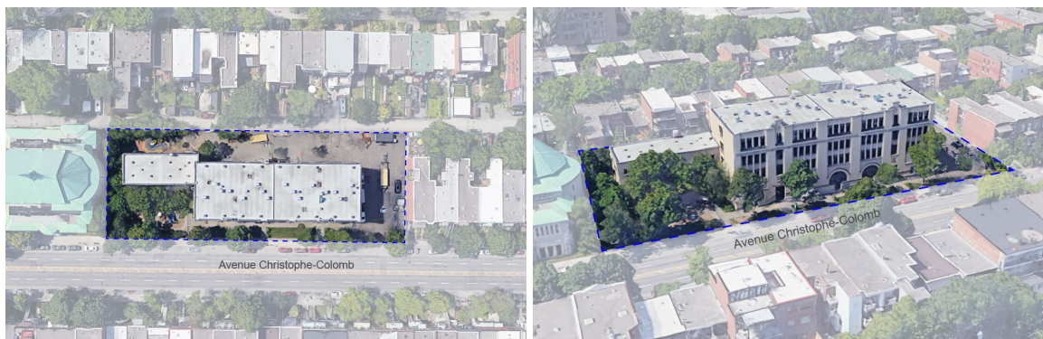
Figure 2. L'école Saint-Arsène (superficie de plancher de 6019 m 2 ). Source : Google Earth, modifié par le CSSDM.
