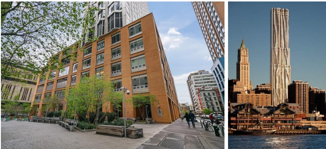
Spruce Street School (Public School 397), Lower Manhattan, intégrée à la tour résidentielle (8th Spruce Street) de 76 étages en acier via un podium de brique de 5 étages : 9 300 m 2 , 600 étudiants de la pré-maternelle à la 8 e (elementary) source : StreetEasy, Dezeen architecte : Frank Gehry
