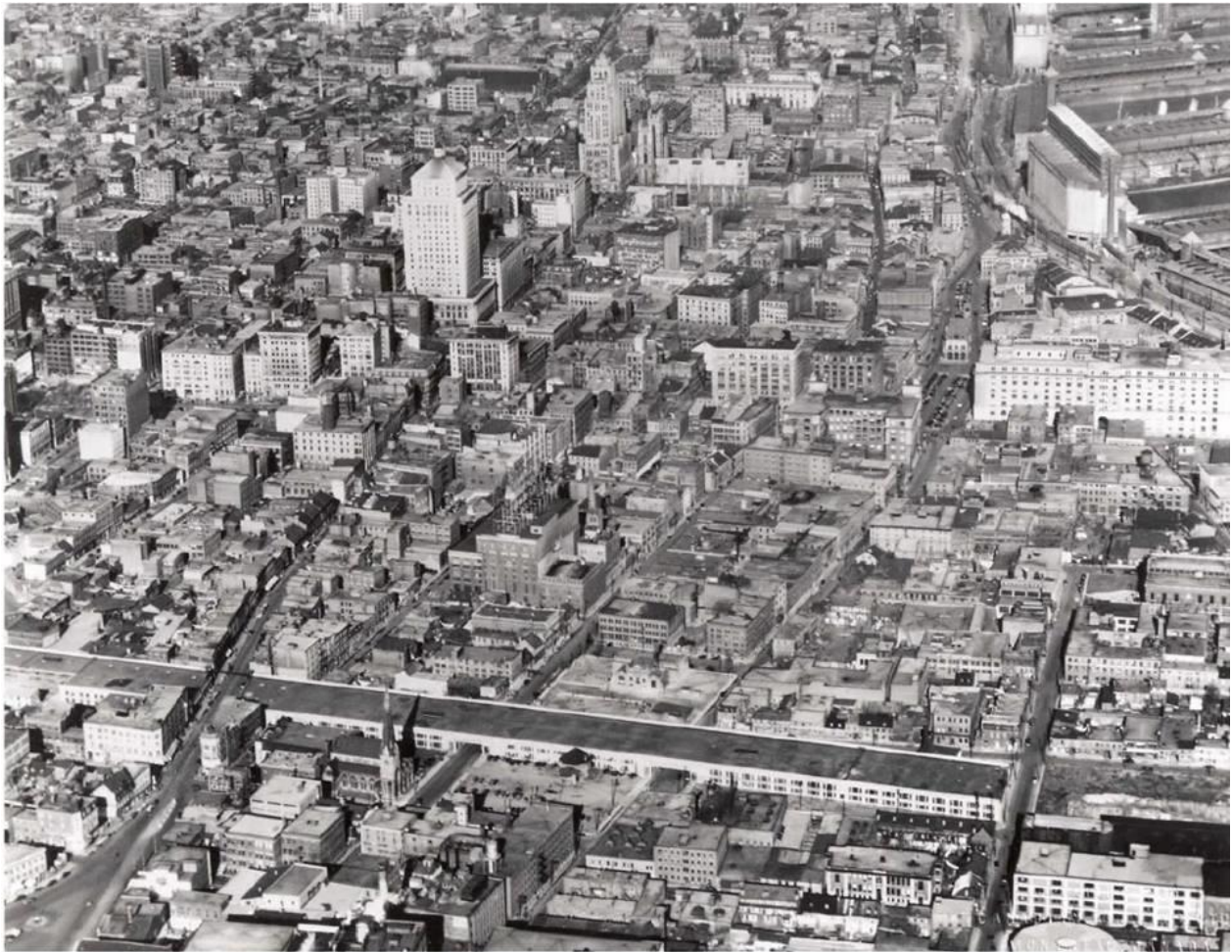
État d'avancement de la construction du bâtiment-pont ferroviaire (sans ses ponts) source : Canadian Airways Limited , circa 1931-32
