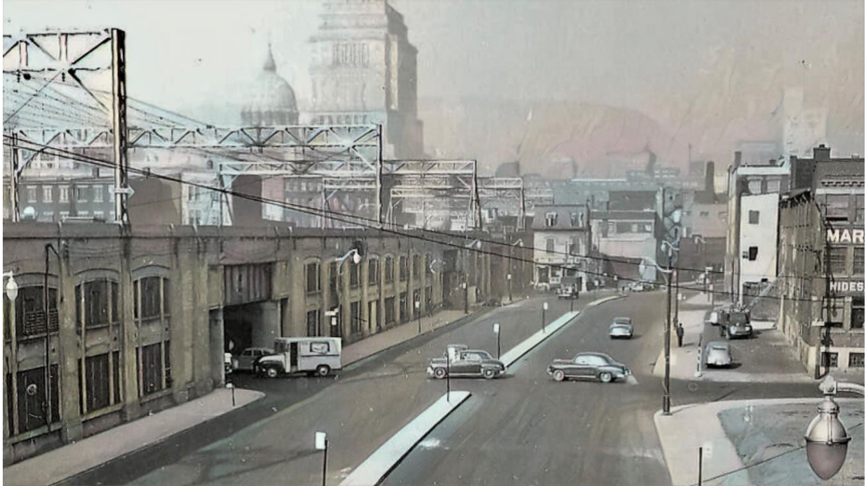
Le bâtiment-pont ferroviaire du CN en octobre 1953 source : AVM. VM94-2513-24
