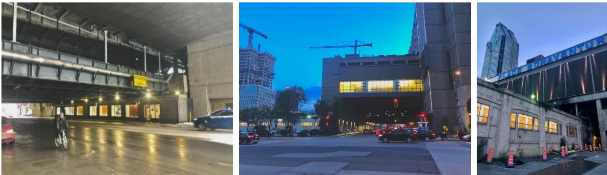
Viaduc 1, rue Saint-Antoine ouest, intégré à la structure de Place Bonaventure source : psc
