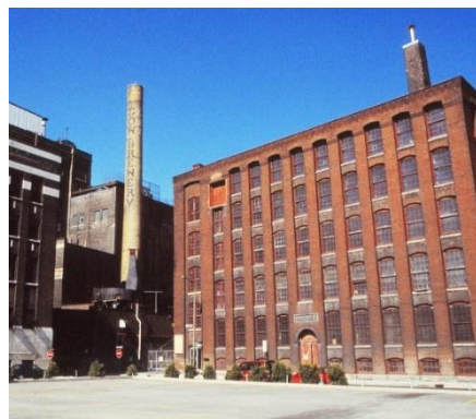
Usine Lowney désaffectée, circa 2000 source : griffintown.org
