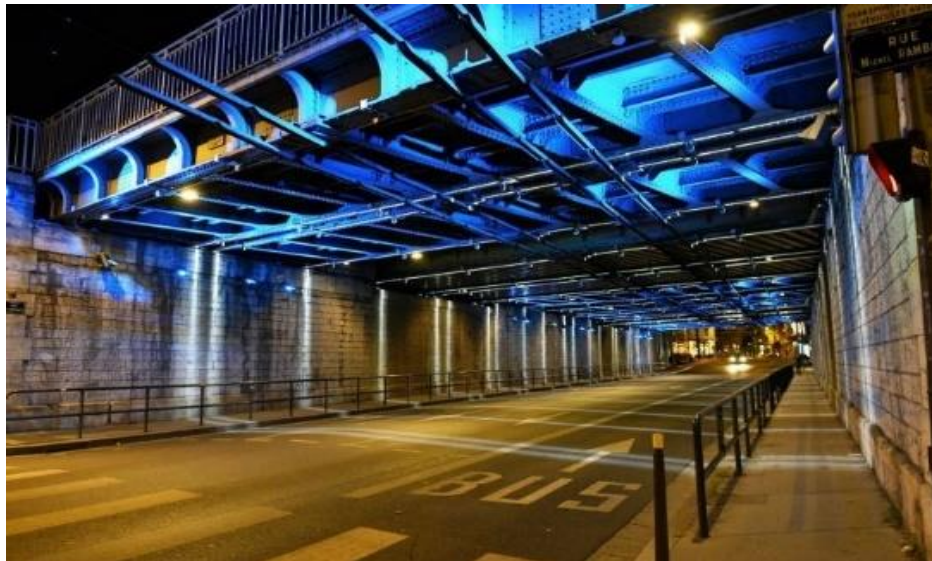
Lyon, ouvrages de la SNCF mis en lumière par EDF source : Le Progrès/Éric Beaulé
