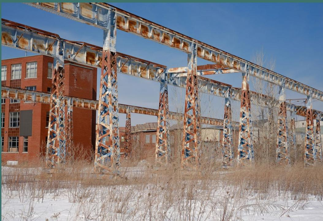
Figure 2 - Ponts roulants de la Dominion Bridge depuis le boulevard Saint-Joseph. Source : Photo prise lors de la visite de terrain le 17 mars 2022
