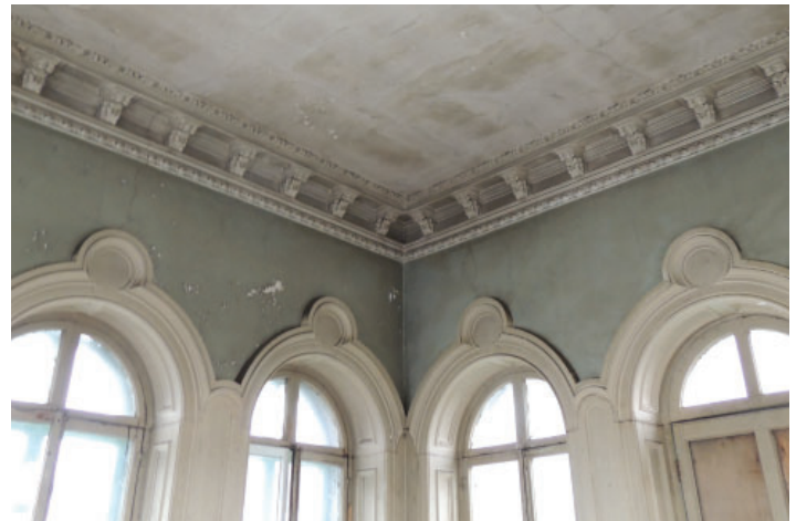
Fig. 30. Pièce au sommet de la tour de Ravenscrag. Photo : EVOQ.
