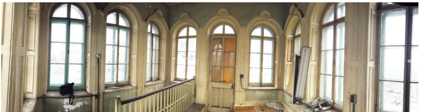
Fig. 68. Panorama de la pièce supérieure de la tour de Ravenscrag, état contemporain. Photo : EVOQ.
