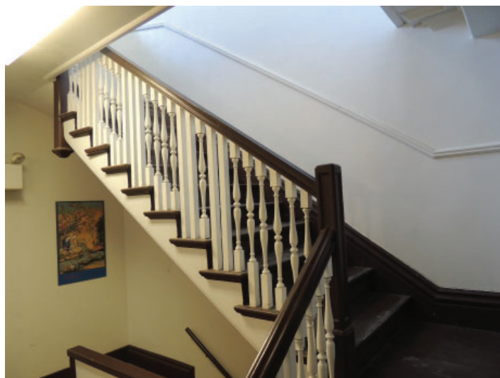
Fig. 46. Escalier de service de Ravenscrag. Photo : EVOQ.
