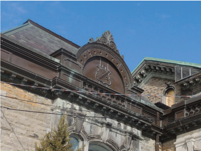
Fig. 17. La lucarne cintrée de la façade sud de l'aile de la salle de bal. Photo : EVOQ.
