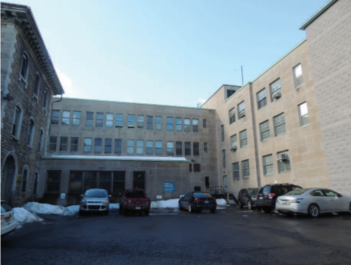
Fig. 60. Institut Allan Memorial, annexe de 1952-1953. Vue de la cour au nord-est de la villa. Photo : EVOQ.
