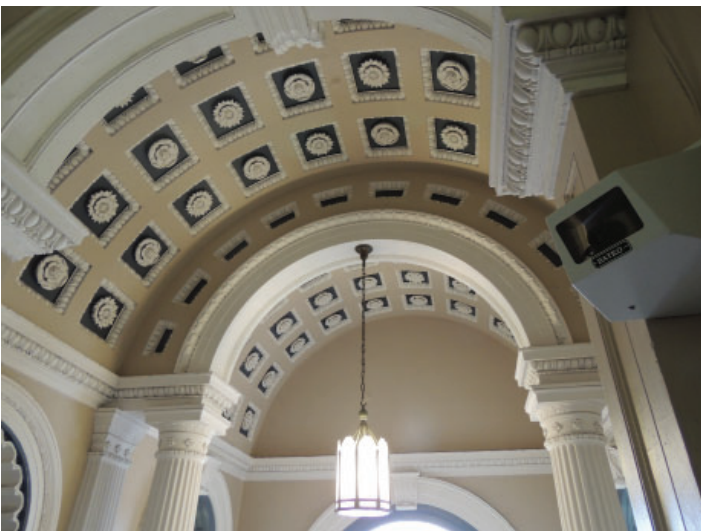
Fig. 43. Vestibule d'entrée. Photo : EVOQ.
