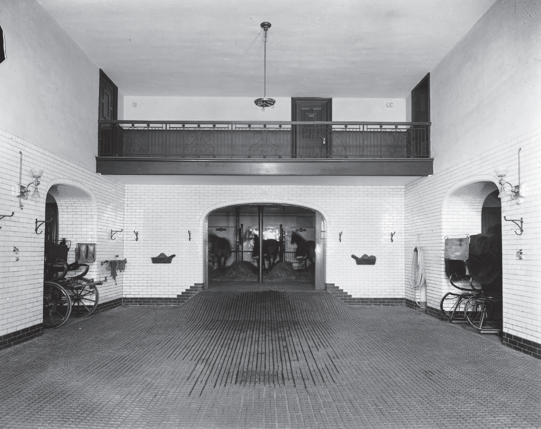
Figure 84 Photographie intérieure des écuries, Ravenscrag. Les chevaux de Sir Hugh Allan vivaient dans des écuries exceptionnelles, aujourd'hui les bureaux de l'Institut Allan Memorial.
