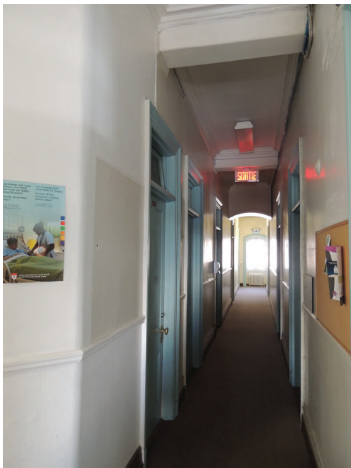
Fig. 74. Corridor de l'aile est de la villa de Ravenscrag. Photo : EVOQ.
