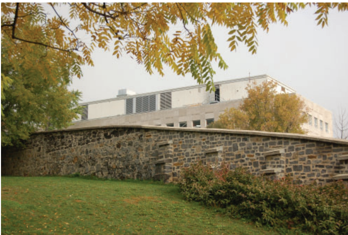
Fig. 34. Mur de clôture de l'ouest en 2012. Photo : Daniel Arbour & Associés.
