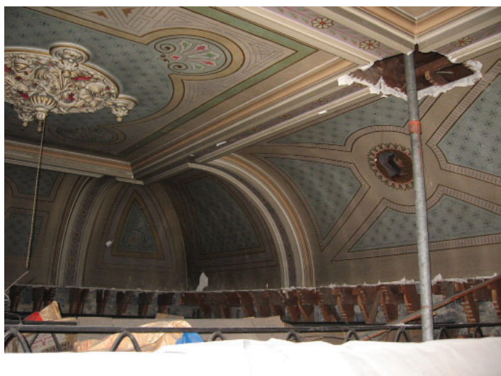
Fig. 22. Plafond d'origine de l'ancienne salle de bal de Ravenscrag. Photo : Matthew Wiviott.
