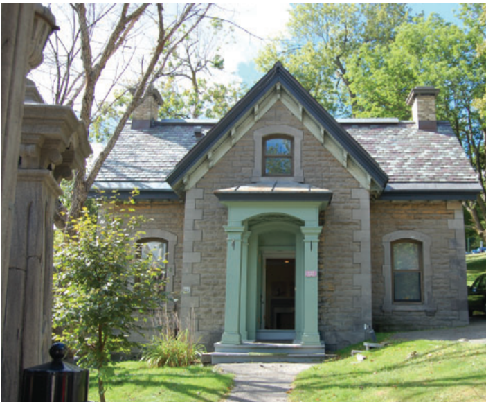
Fig. 35. Maison du gardien. Détail d'une photo de la Ville de Montréal.
