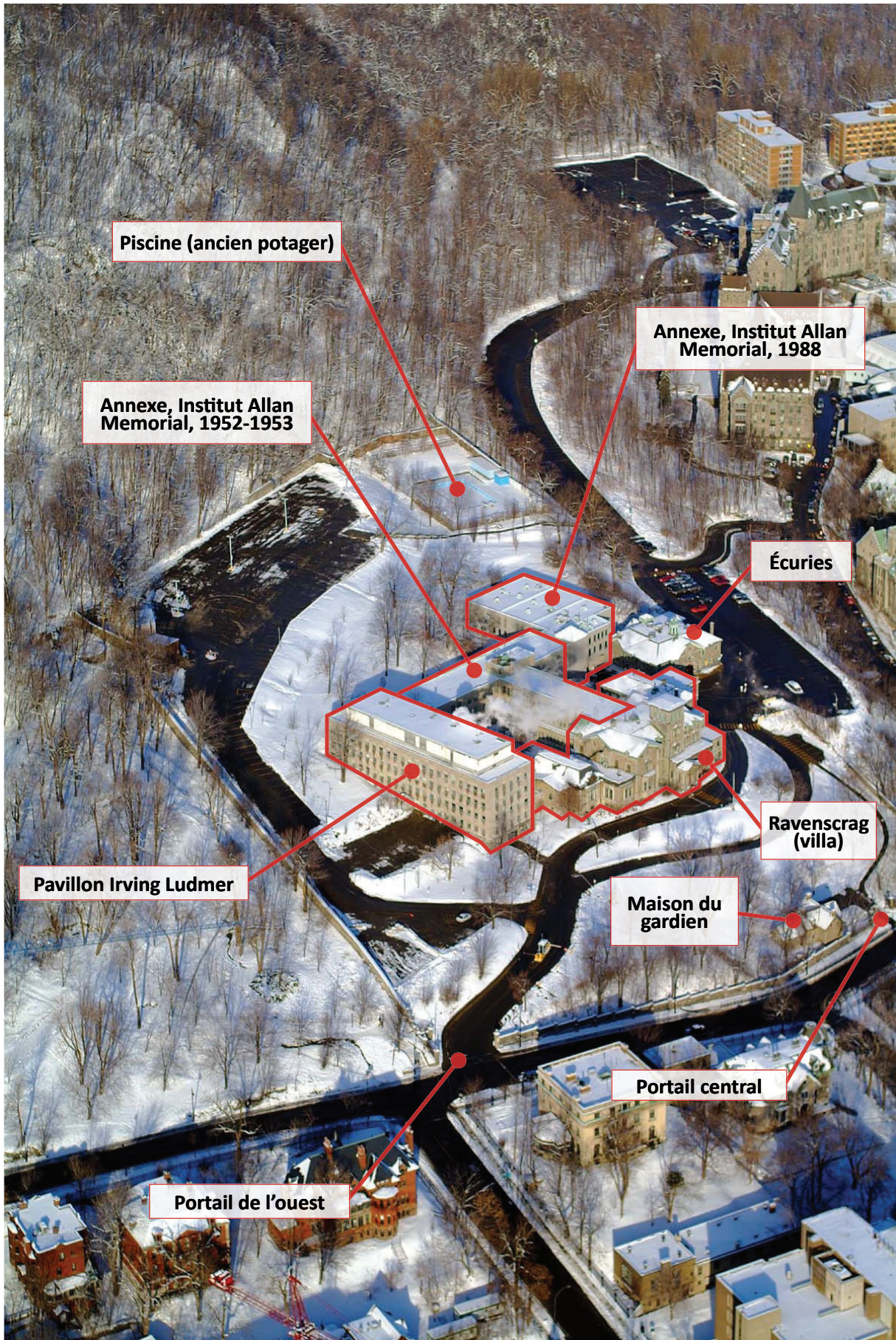
Fig. 2. Le site de Ravenscrag / Institut Allan Memorial et ses composantes. Photo de base : Ville de Montréal, 2006-2007.
