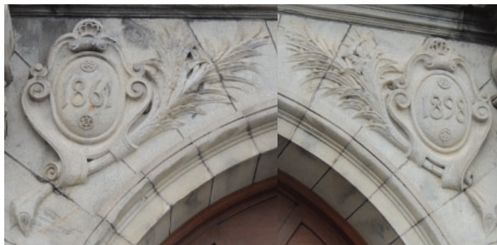
Fig. 49. Armoiries à l'entrée des écuries. Celles à gauche indiquent la date de construction d'origine des écuries (1861) et celles à droite indiquent la date des rénovations (1898). Détails de photos d'EVOQ.
