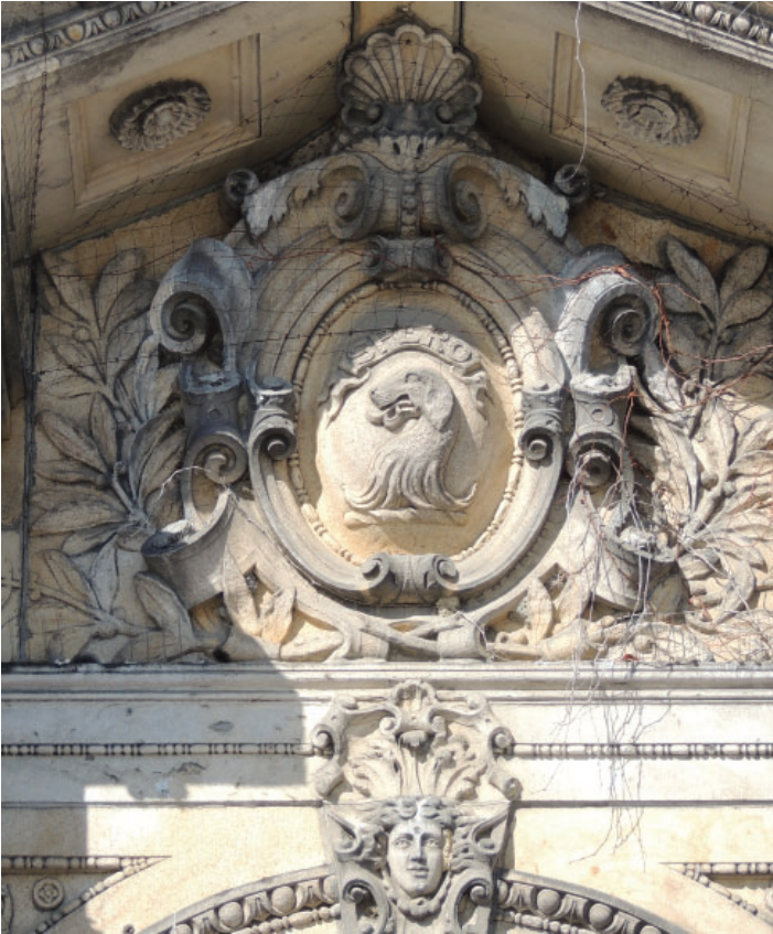
Fig. 42. Écusson du portique d'entrée. Photo : EVOQ.
