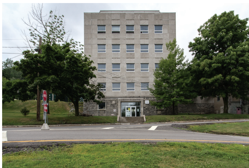
Figure 89 Photographie extérieure de l'Institut Allan Memorial, 2012. Le pavillon de recherche et formation Irving Ludmer, construit en 1963, affiche une façade moderne et régulière.
