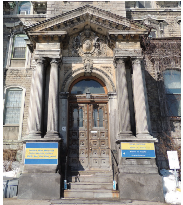
Fig. 40. Portique d'entrée. Détail de photo d'EVOQ.
