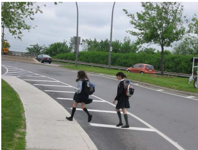
Photo 2.3 : Traversée d'écolières de l'est vers le trottoir du viaduc
