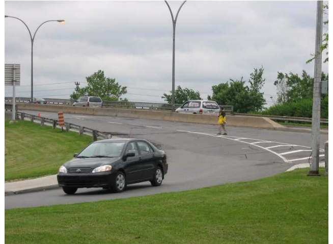
Photo 2.2 : Traversée d'un piéton de l'est vers le trottoir du viaduc
