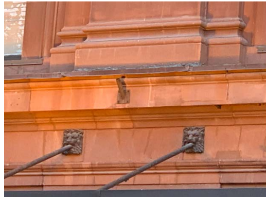
Ancrages de la marquise, en forme de bas-reliefs de lion.
