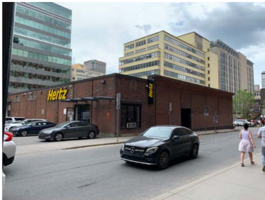
Façades Nord et Ouest.
