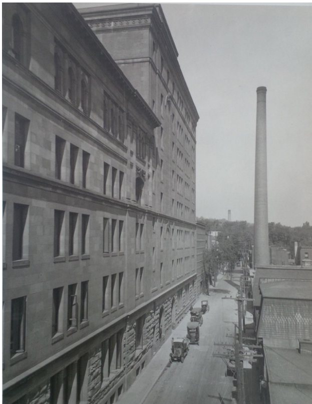
Date inconnue (après 1923). Source : Centre canadien d'architecture, cote 03Arc275N.
