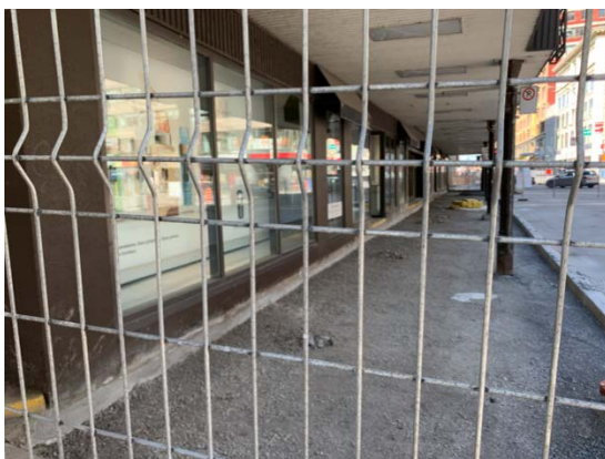
Façade du rez-de-chaussée sous la marquise sur Sainte-Catherine
