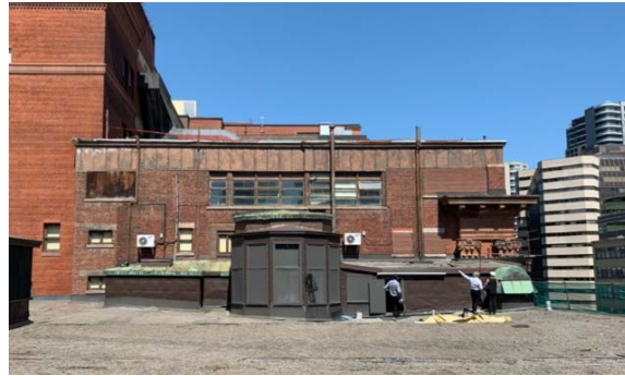
Façade sud de la partie d'étage ajouté et des appentis.
