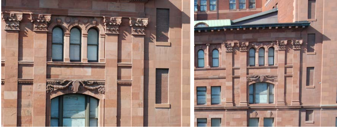
Travée latérale de la façade principale
