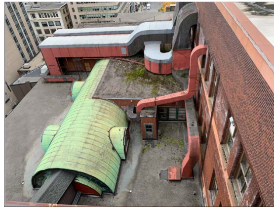
Toiture, dont la partie cintrée abritait à l'origine la galerie d'art.
