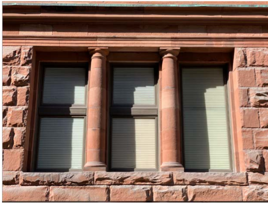
Colonnets engagées des ouvertures du rez-de-chaussée
