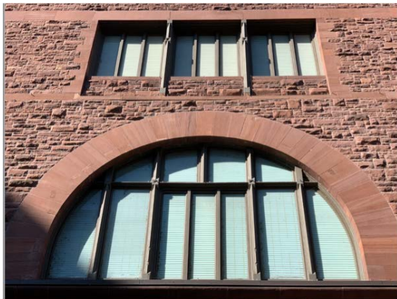
Ouvertures des deuxième et troisième étages de la façade sur Aylmer
