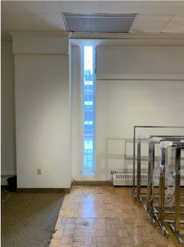
Une fenêtre du 7 e étage.
