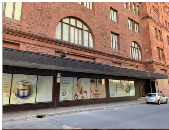
Marquise de la façade sur Aylmer
