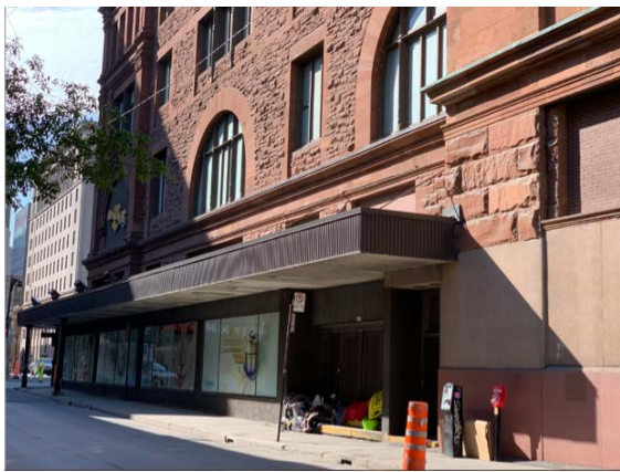
Marquise de la façade sur Aylmer
