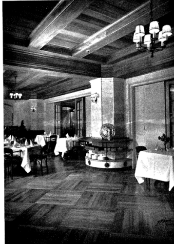
Grill room, 1927 (?) Source : « Henry Morgan & Company, Limited, Departmental Store, Montreal », Construction, septembre 1927, p.306.
