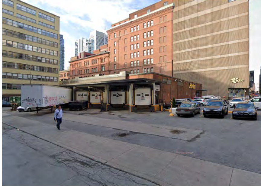
Figure 2-21 Quais de livraison de La Baie d’Hudson
