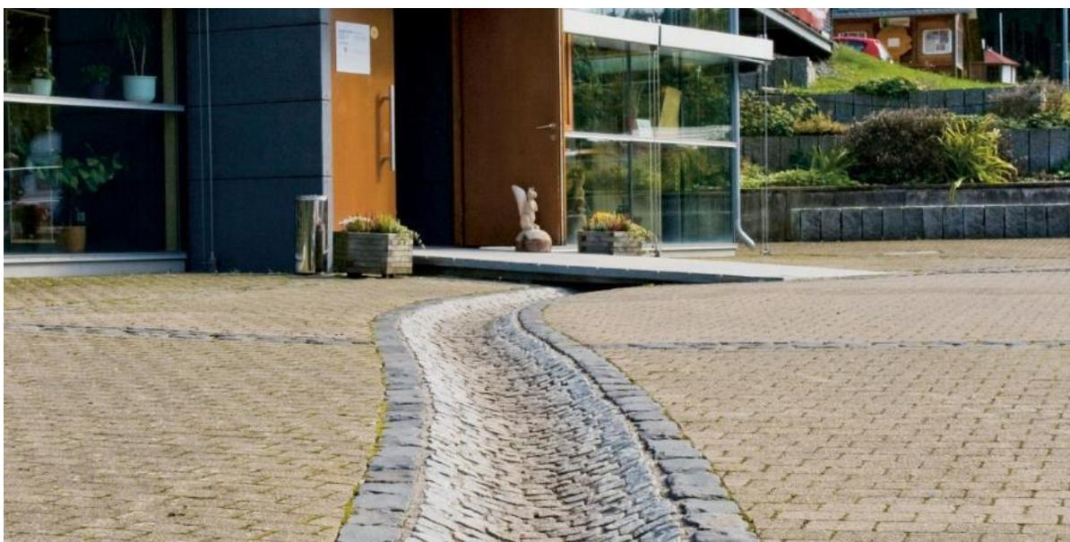
Figure 30. Exemple d'un aménagement d'une rigole.
