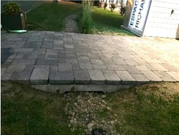
Figure 31. Exemple d'une traverse.
