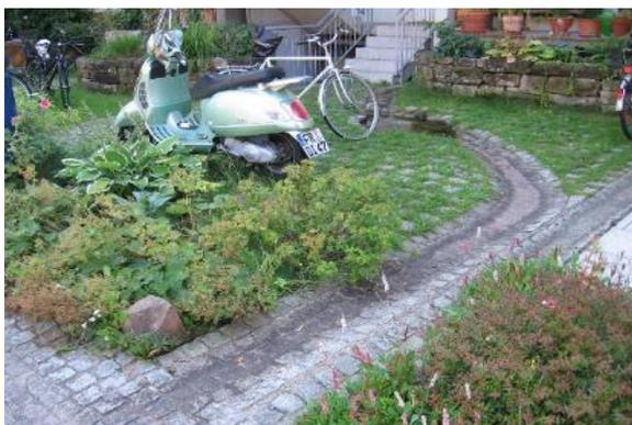
Figure 28. Rigole résidentielle d'eaux pluviales (Fribourg-en-Brisgau).
