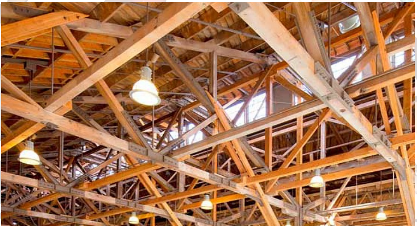
Construction LEED avec ossature en bois
