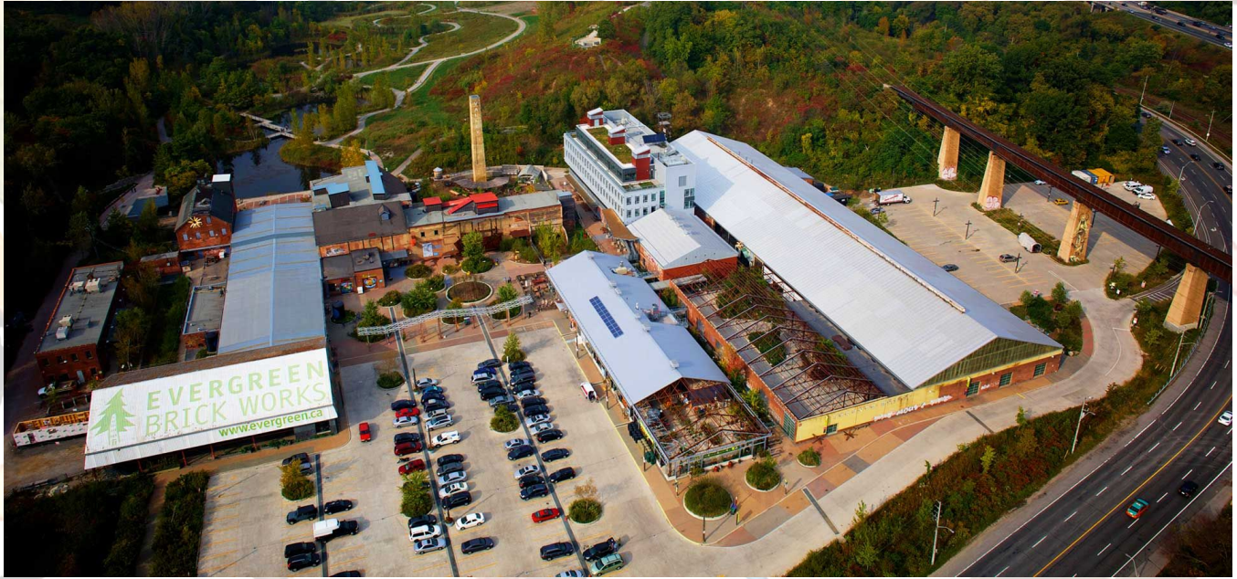
Vue aérienne du complexe entier
