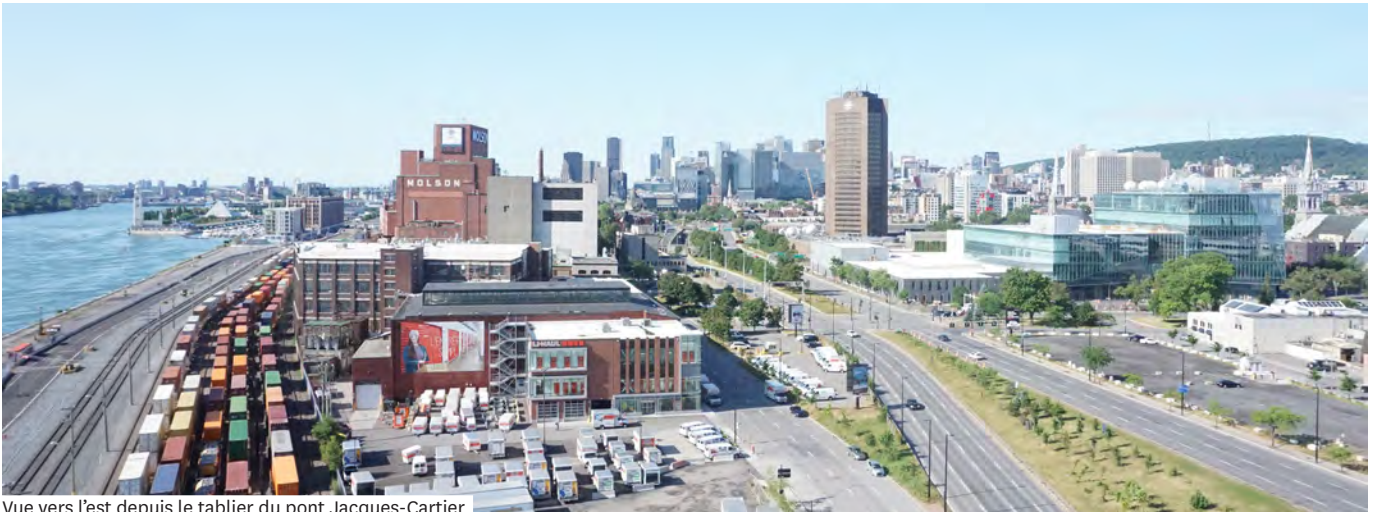
Vue vers l'est depuis le tablier du pont Jacques-Cartier
