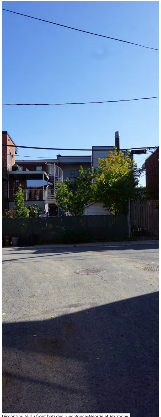
Discontinuité du front bâti des rues Prince-George et Harmony
