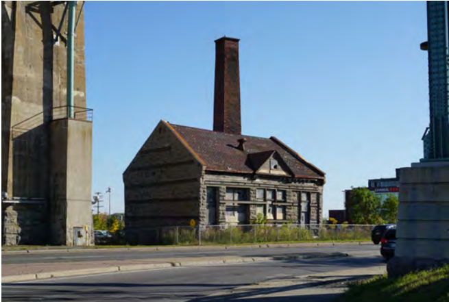
Ancienne station de pompage Craig - 131, rue Viger
