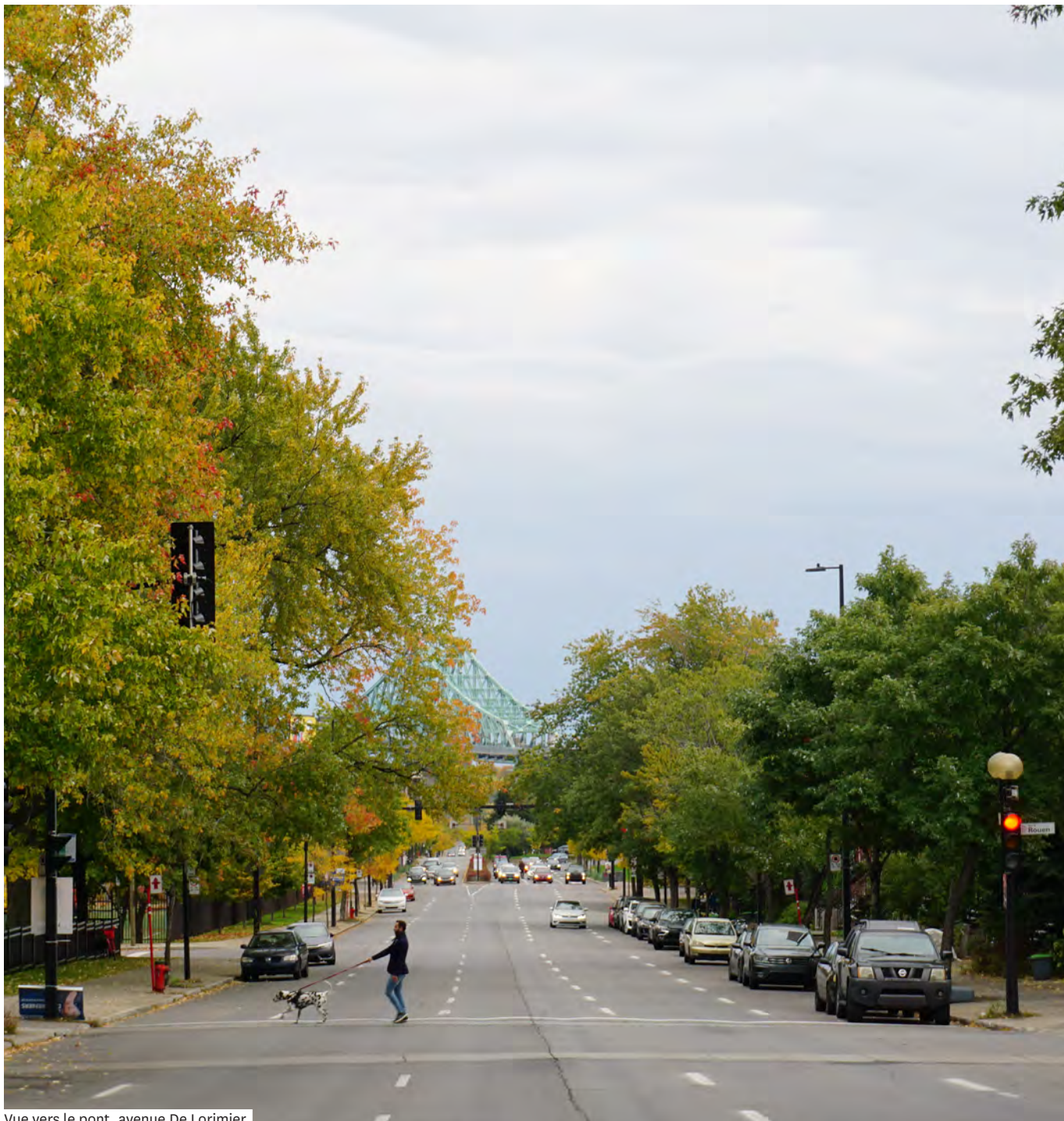
Vue vers le pont, avenue De Lorimier
