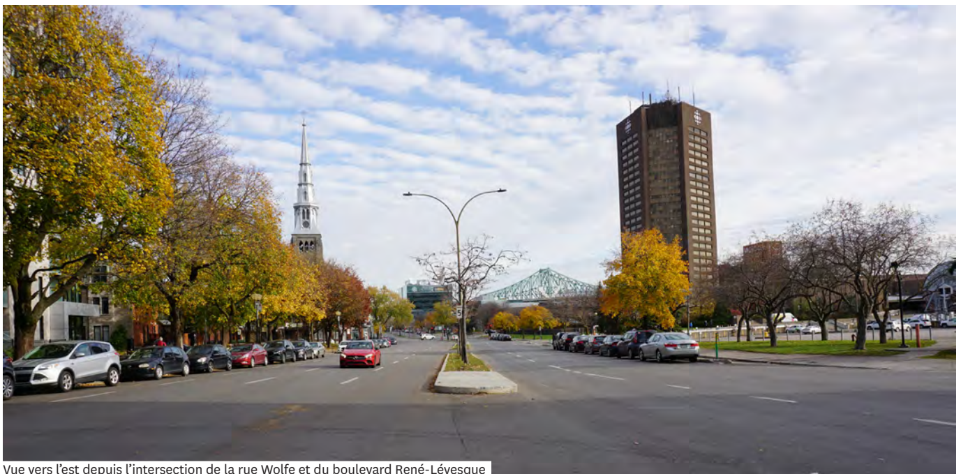
Vue vers l'est depuis l'intersection de la rue Wolfe et du boulevard René-Lévesque
