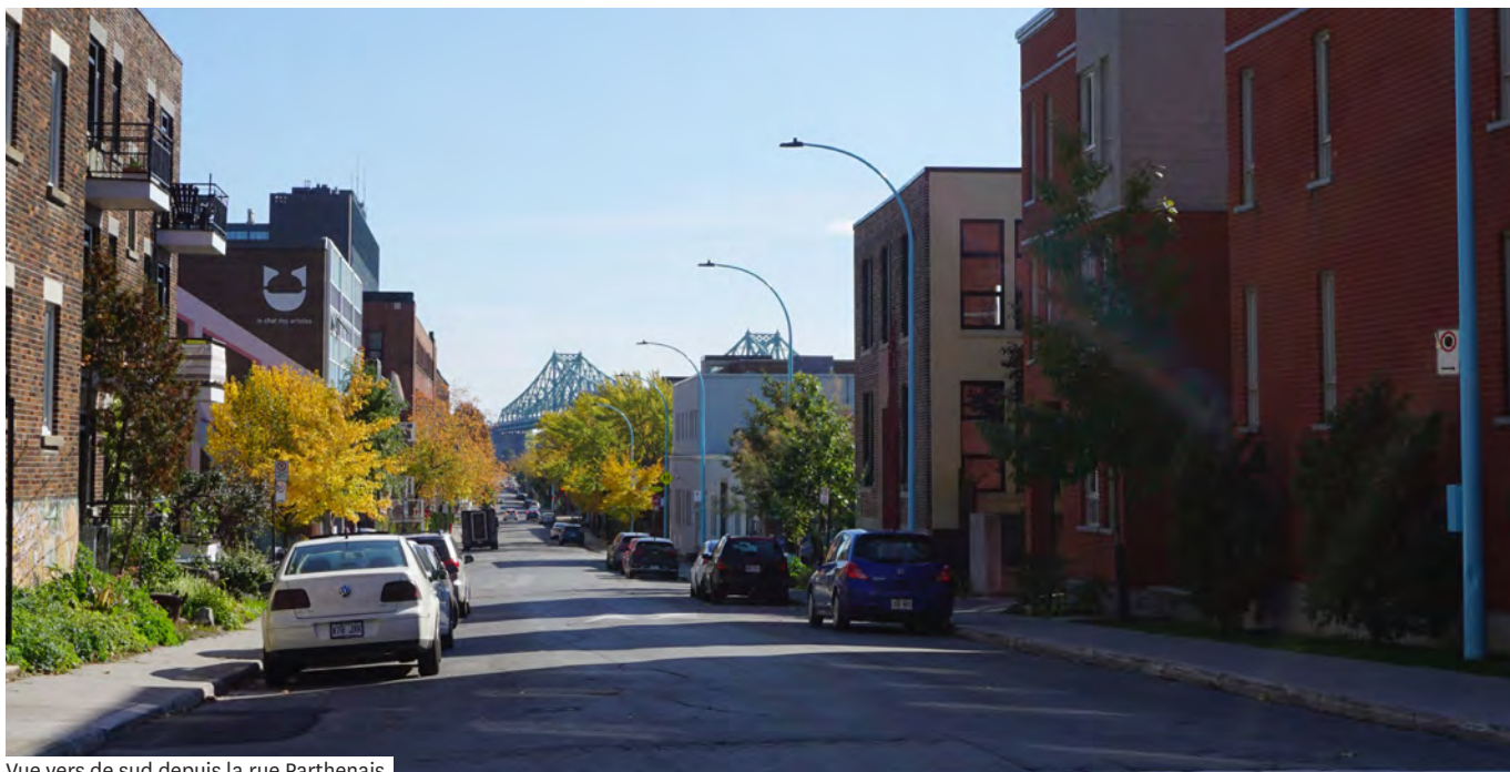
Vue vers de sud depuis la rue Parthenais
