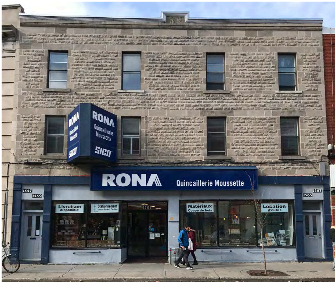
1557-1567, rue Ontario Est
