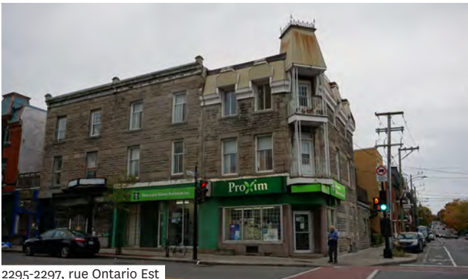
2295-2297, rue Ontario Est
