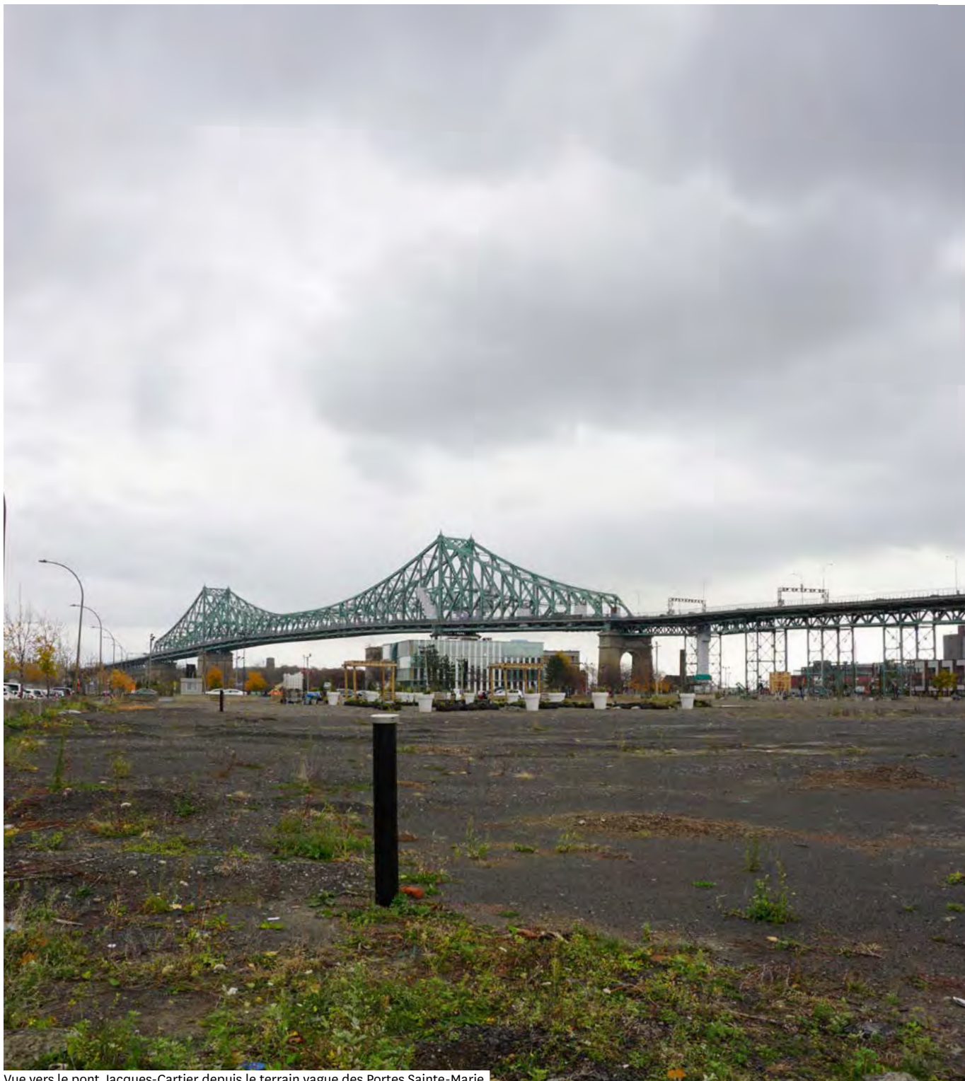
Vue vers le pont Jacques-Cartier depuis le terrain vague des Portes Sainte-Marie
