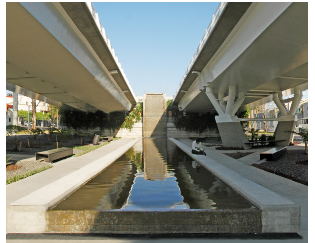
Sous le viaduc : Parc linéaire Matute Remus, Guadalajara, Mexique
