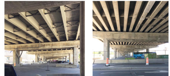
Passage sous l'autoroute Bonaventure, 2019. Photo : Lucette Lupien
