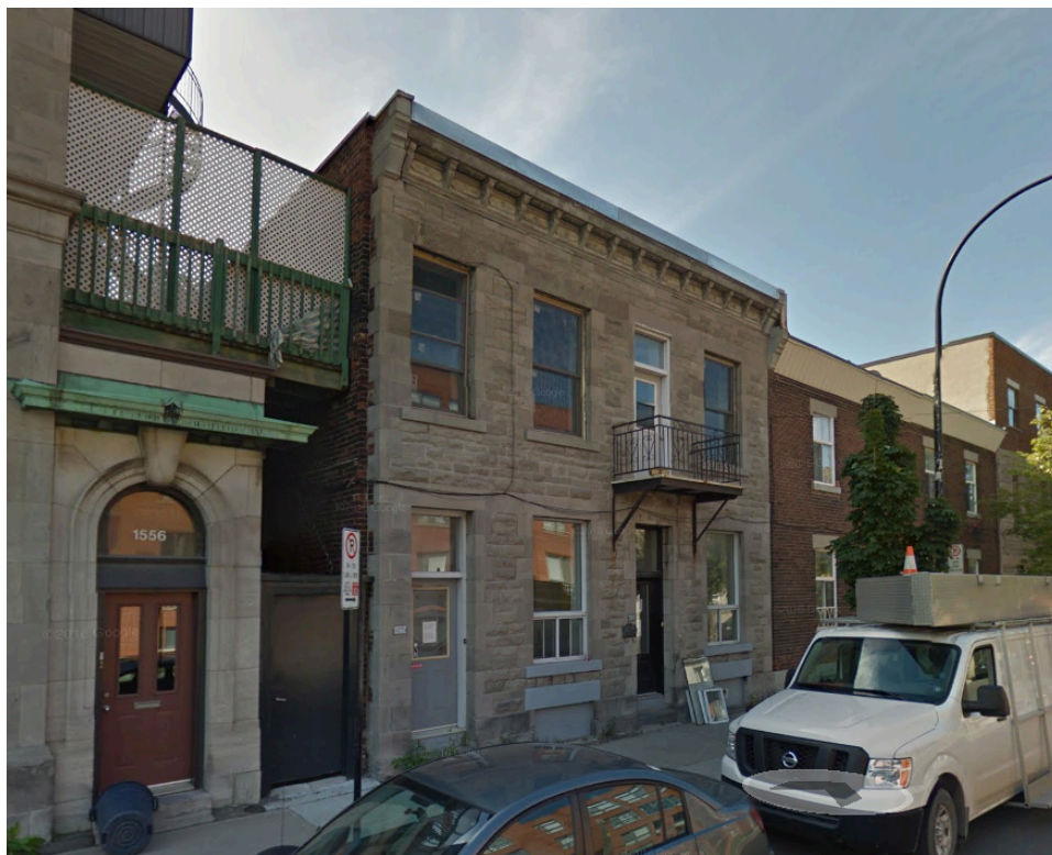
1562-1564, rue Du Centre, 2016 (Google Streetview)
