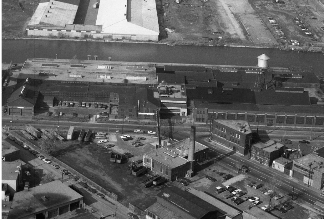
Vue d'ensemble du complexe de la Canadian Switch and Spring, 1972 (Archives Ville de Montréal)
