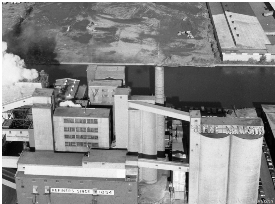
Vue aérienne des silos dans l'ensemble du complexe Redpath, 1972 (Archives Ville de Montréal)
