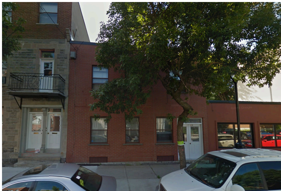
1576-1578, rue Du Centre, 2016 (Google Streetview)
