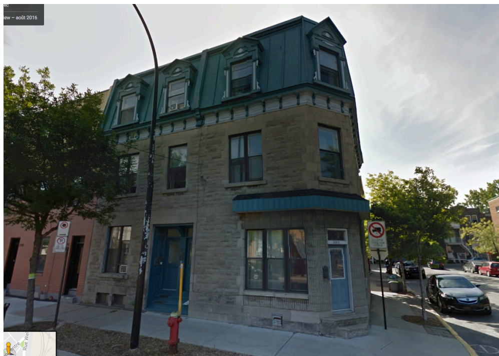
1594-1604, rue Du Centre, 2016 (Google Streetview)
