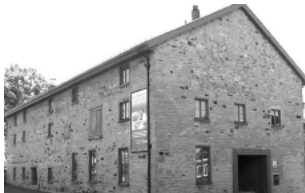
19.E.2 Immeuble du complexe de la brasserie Dawes au 2875, boulevard Saint-Joseph
