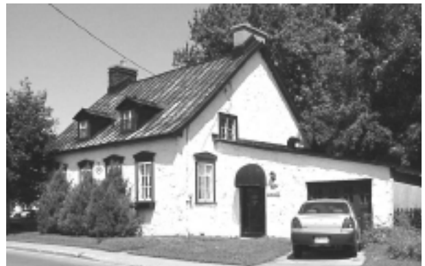
19.E.2 La maison Picard au 5430, boulevard Saint-Joseph
