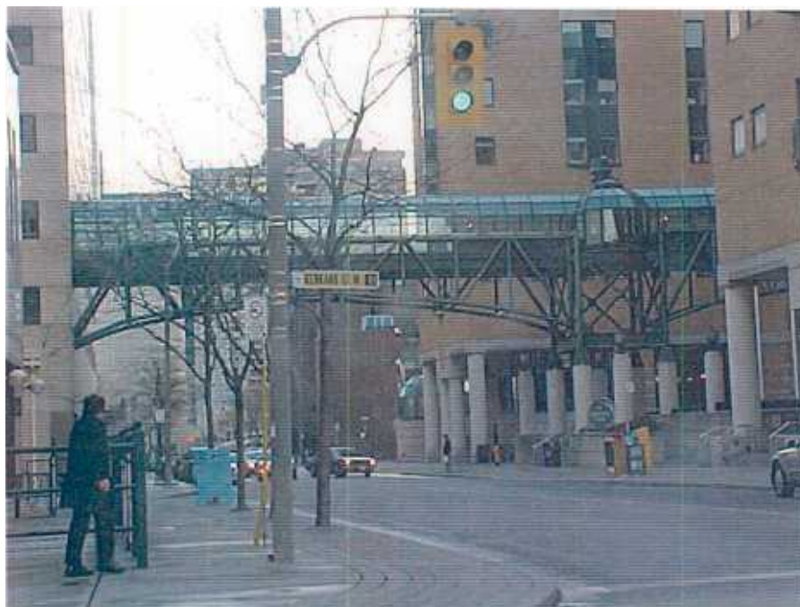
Figure 17 : Passerelle du Sick Kids Hospital de Toronto
