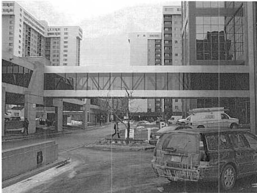
Figure 13 : Passerelle du métro de Longueuil
