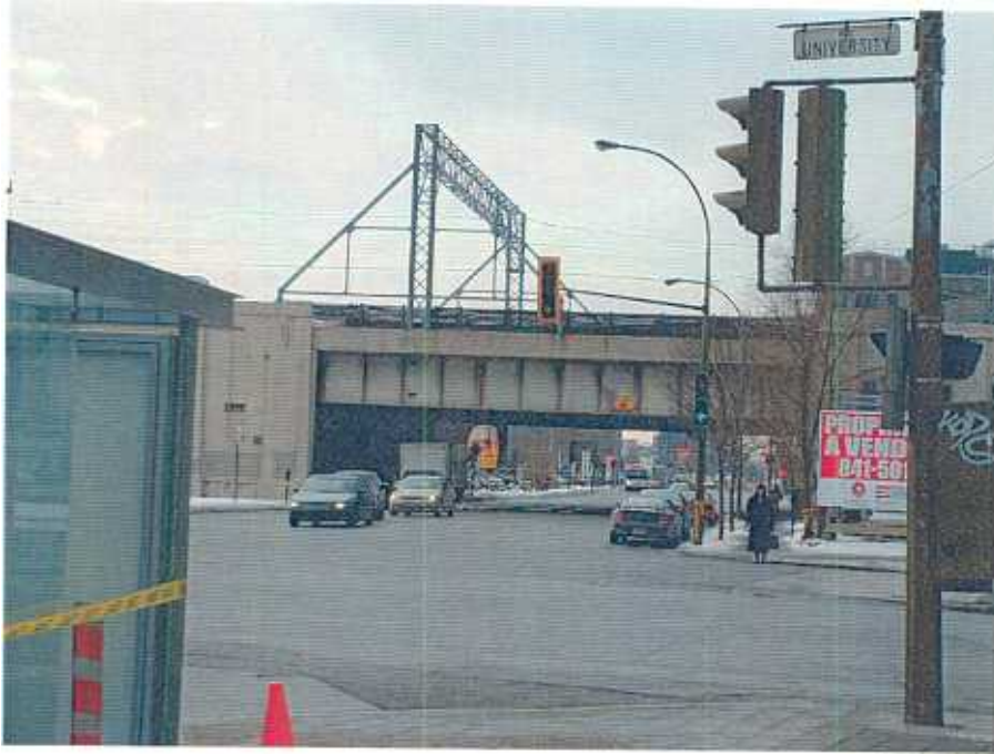
Figure 21 : Viaduc sur la rue Notre-Dame
