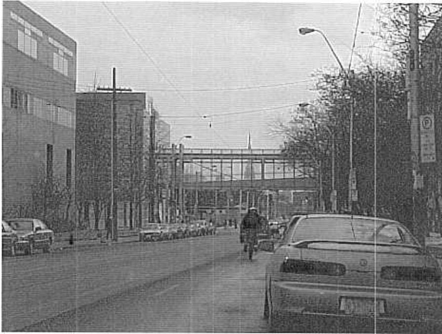
Figure 7 : Passerelle à l'Université Ryerson à Toronto
