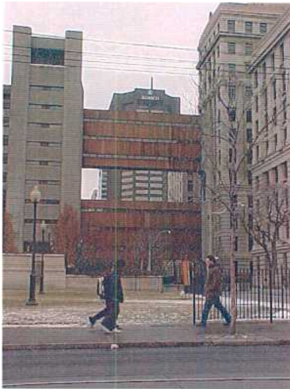
Figure 14 : Passerelle de l'hôpital Mount Sinai à Toronto
