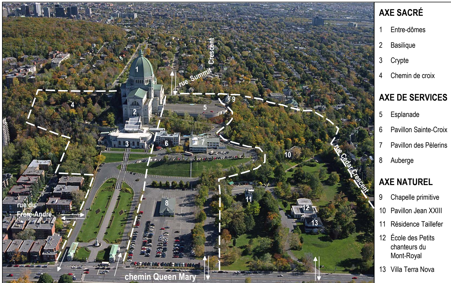
Figure 1 Photographie du site de l'Oratoire Saint-Joseph du Mont-Royal situant les accès au site (entrées ↑ et sorties ↓) et montrant de façon schématique le découpage entre les trois axes de la propriété (adapté du document 21, diapositive 35) :
