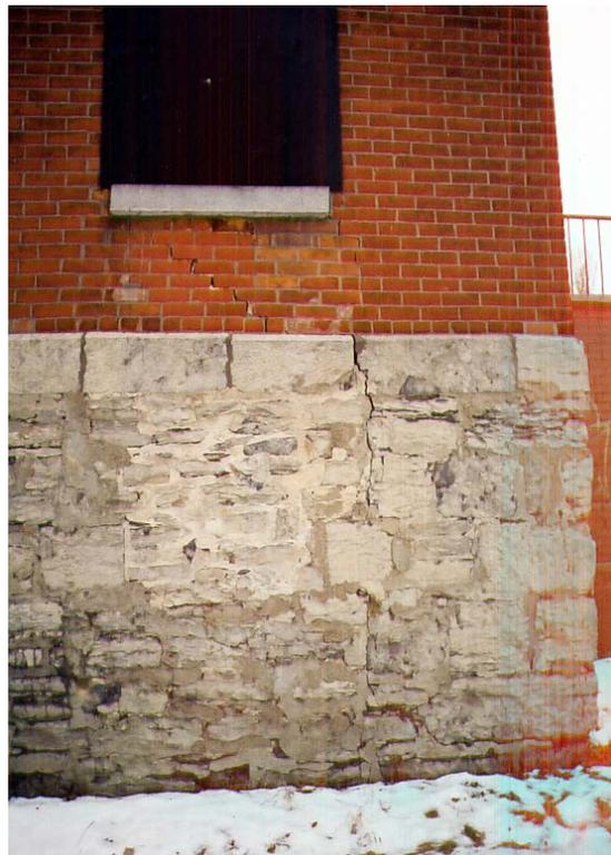
Figure 34 : Fissures qui affectent le coin droit de la façade principale et mauvais état des joints de maçonnerie (C. Lefebvre, 2002).
