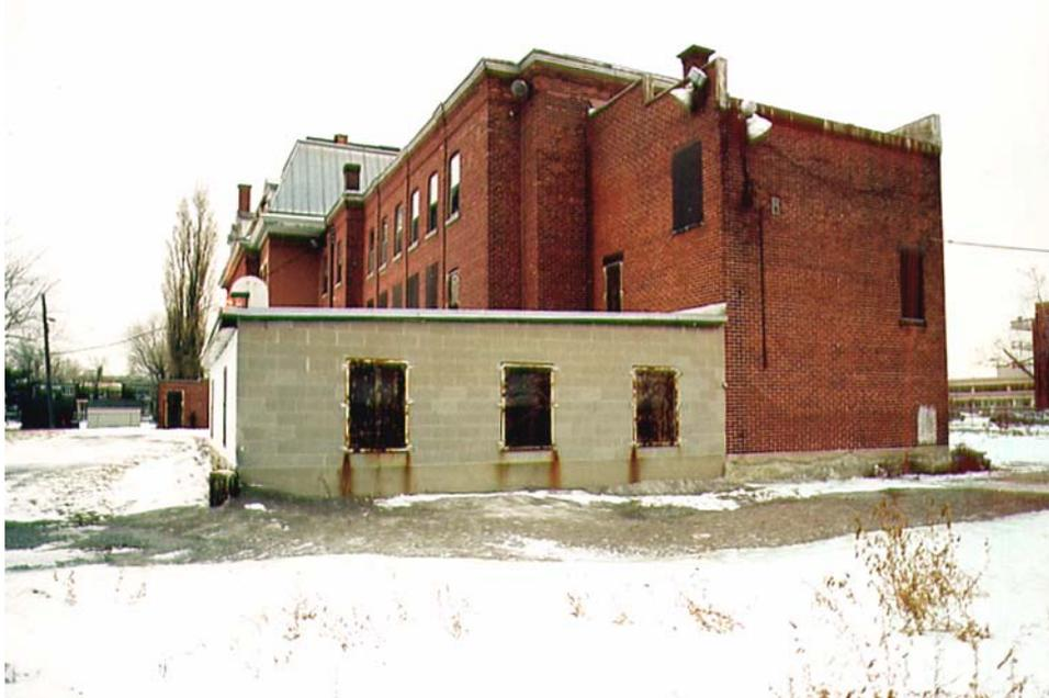
Figure 31 : Élévation arrière montrant l'ajout en bloc de béton (C. Lefebvre, 2002).
