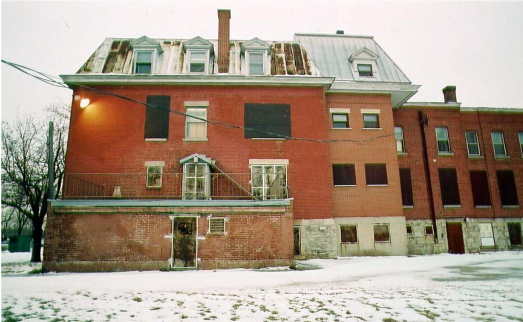
Figure 29 : État actuel, élévation ouest. À noter le mauvais état du revêtement métallique de la toiture du bloc principal et le nouvel ajout de 1978 légèrement plus haut (C. Lefebvre, 2002).
