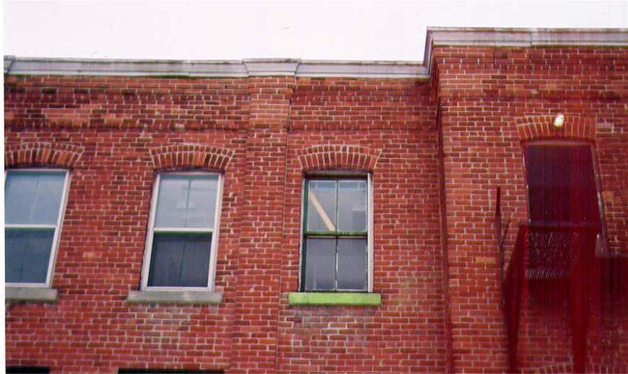
Figure 33 : Détail du couronnement de l'aile arrière - solin en mauvais état et fenêtres d'aluminium surmontées d'arcs surbaissés en brique (C. Lefebvre, 2002).
