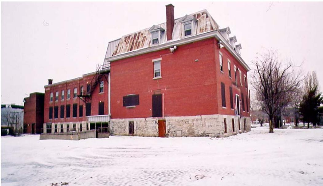
Figure 30 : État actuel, élévation est. On peut voir l'oxydation de la toiture métallique, la nouvelle entrée située derrière le bloc principal, au niveau du sous-sol, et l'absence du portique avant. (C. Lefebvre, 2002).
