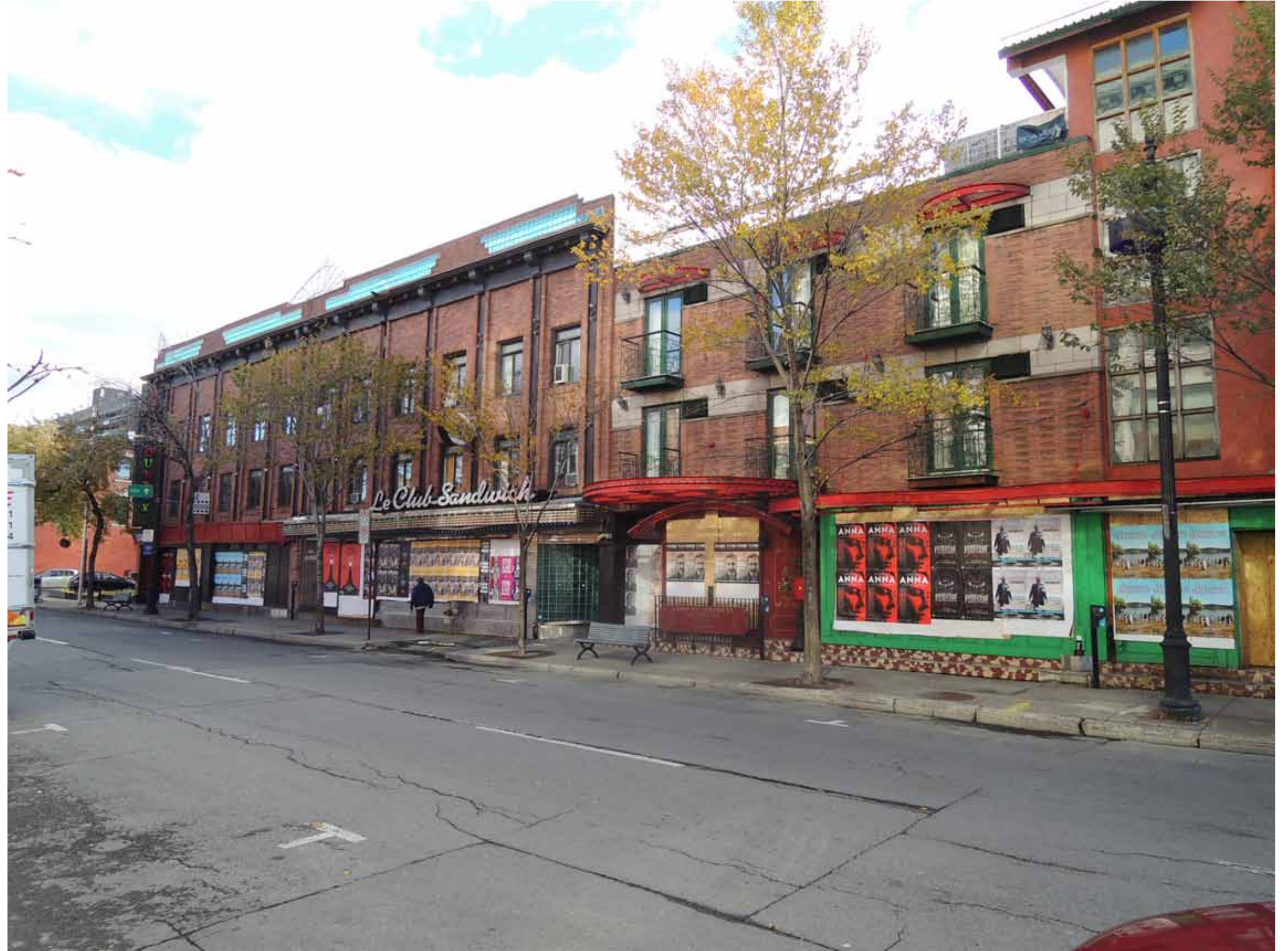
Façade sur la rue Sainte-Catherine
