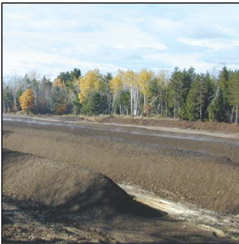
Site de compostage en andains retournés sur aire ouverte Photo : SOLINOV
