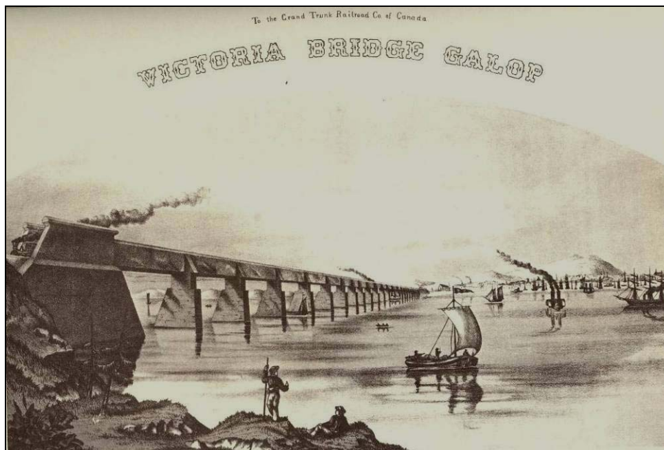
Le pont Victoria du Grand Tronc en 1860
