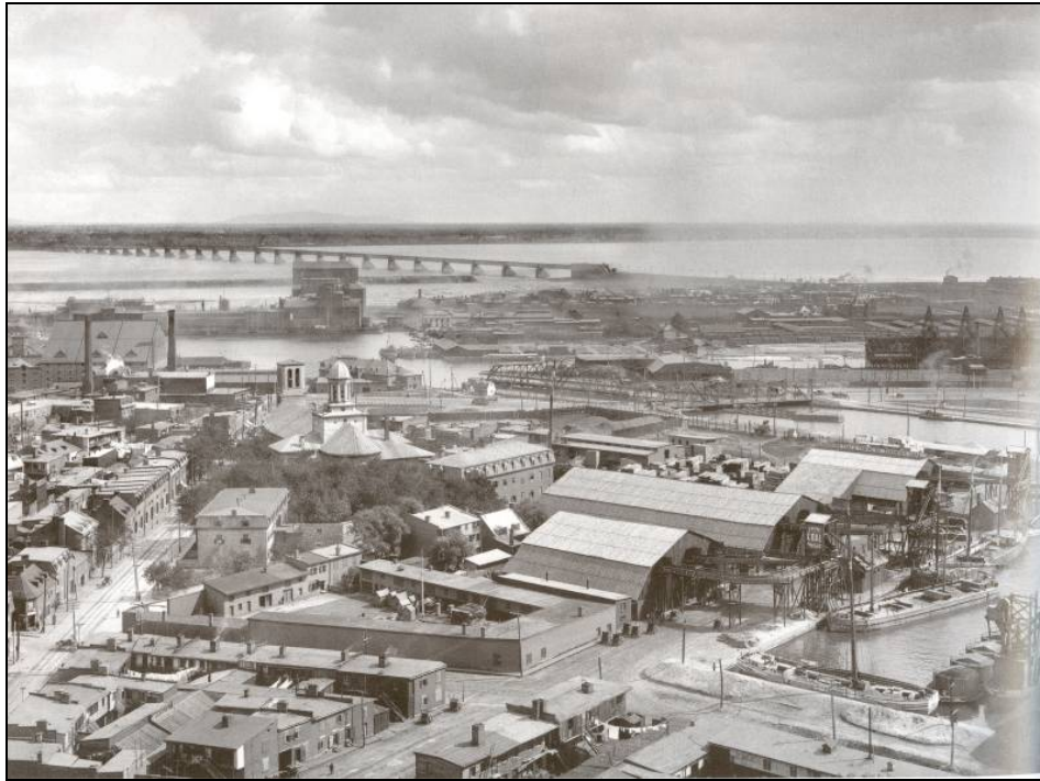
L'église Ste-Anne de 1854 au milieu des maisons ouvrières et des hangars de charbon en 1896
