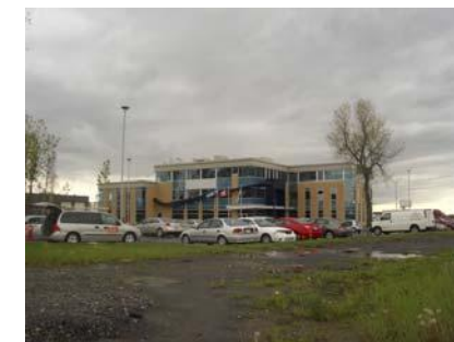
Bureaux situés dans la portion industrielle du projet Brossard-sur-le-Golf
