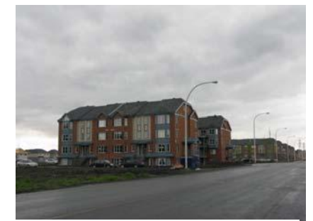
Secteur résidentiel de moyenne densité en construction situé à proximité du stationnement Chevrier
