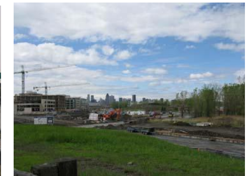
Campus Bell en construction sur la pointe nord de l'Île-des-Sœurs à partir du pont Champlain
