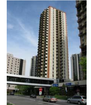
Immeuble de la Place Charles-Lemoyne – Passerelle reliant les bâtiments entre eux
