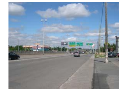
Boulevard Taschereau, panneaux autoroutiers et clôture séparatrice
