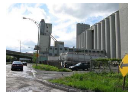
Silos situés à l'extrémité Ouest du Quai Biderbike
